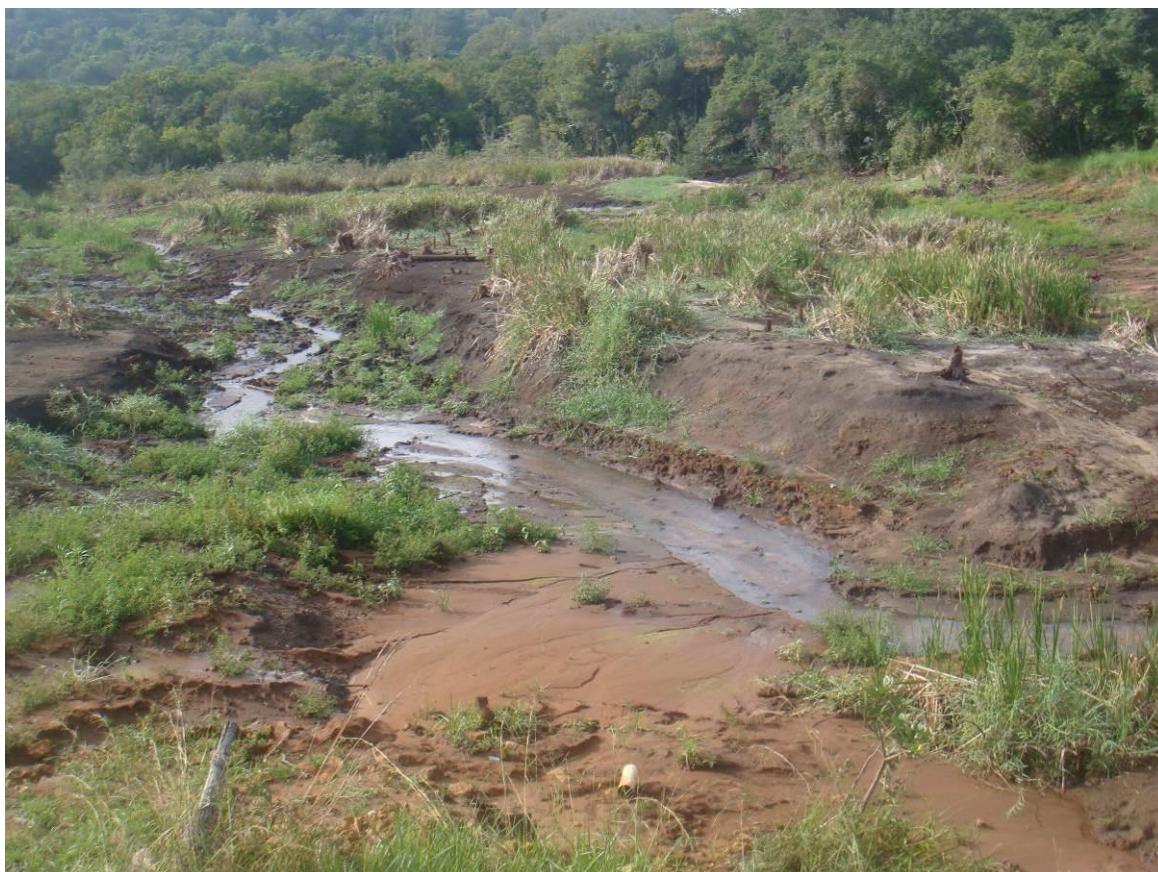
Apêndice 2.3.6.1M. Córrego do Açude (ponto 5), no local onde houve o rompimento da barragem.
