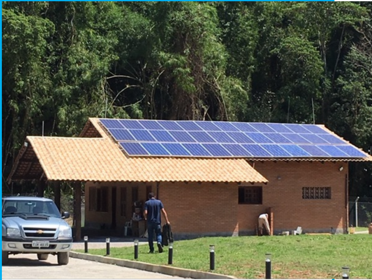
Foto 1 – Base de Proteção da Estrada do Rio Pardo
