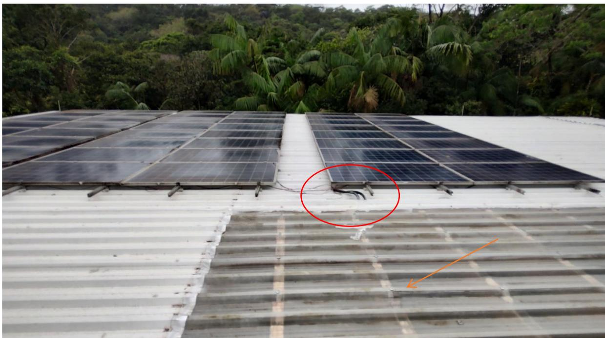
**Figura 3** – Eletroduto existente que deverá ser trocado e área de 26,88m<sup>2</sup> de policarbonato transparente que será removido e substituída por novas.
