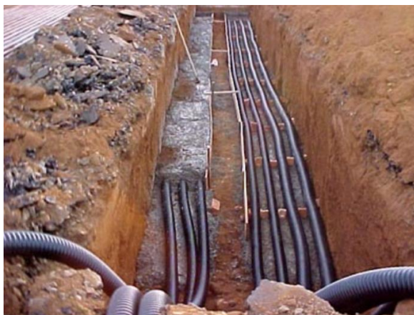
Figura 02 – Exemplo de circuitos elétricos enterrados
