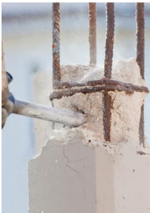
Foto 1: Ilustração - Demolição de pilar
