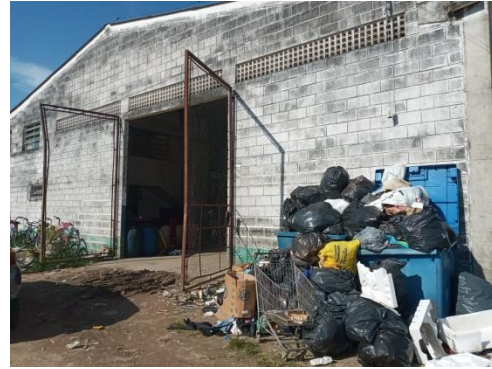
Imagem 15 – Galpão da cooperativa
