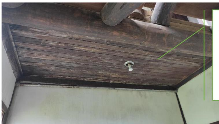
Deverá ser substituído os forros instalados na parte de baixo dos patamares da escada. Os mesmos deverão receber imunizante e pintura em verniz
