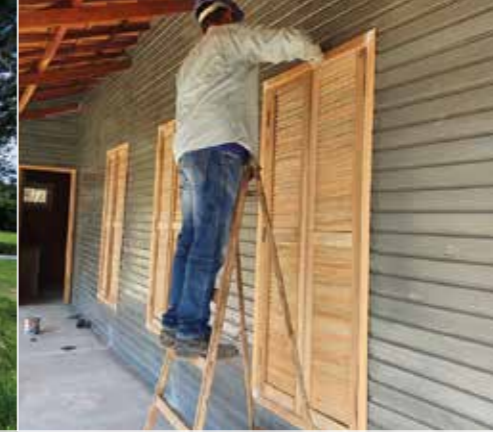
Centro de Visitantes: lixamento para pintura de caixilhos.
