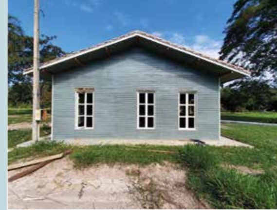
Centro de Visitantes: instalação de caixilhos.
