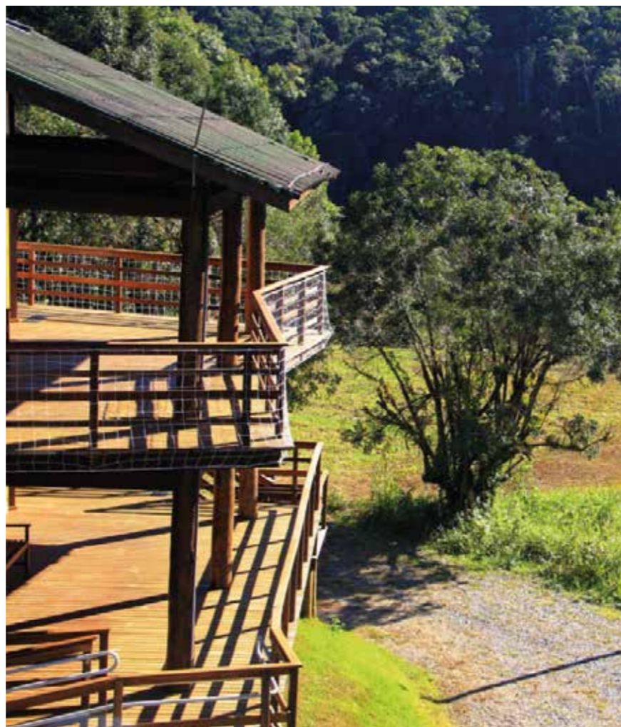
Vista parcial da Pousada Lontra, no PEI.
