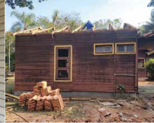
Museu: remoção de telhas.
