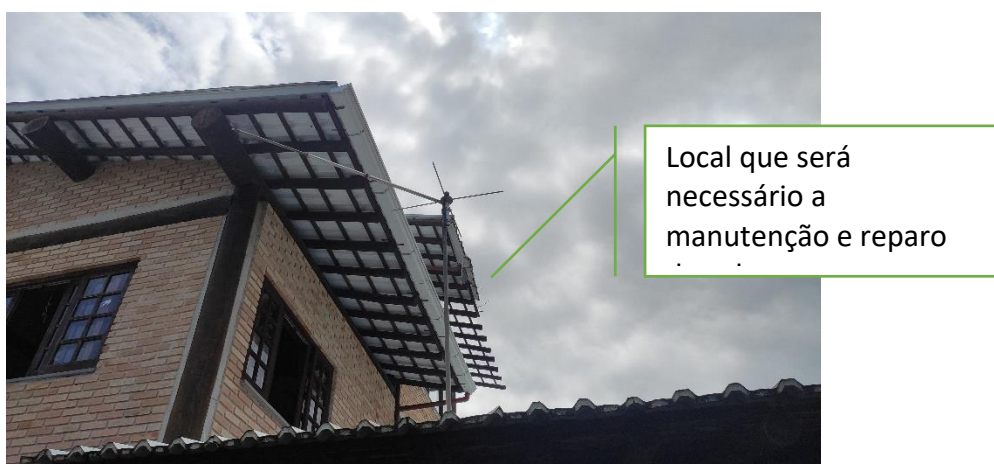
Foto 2: ELEVÇÃO A - Trecho de intervenção
