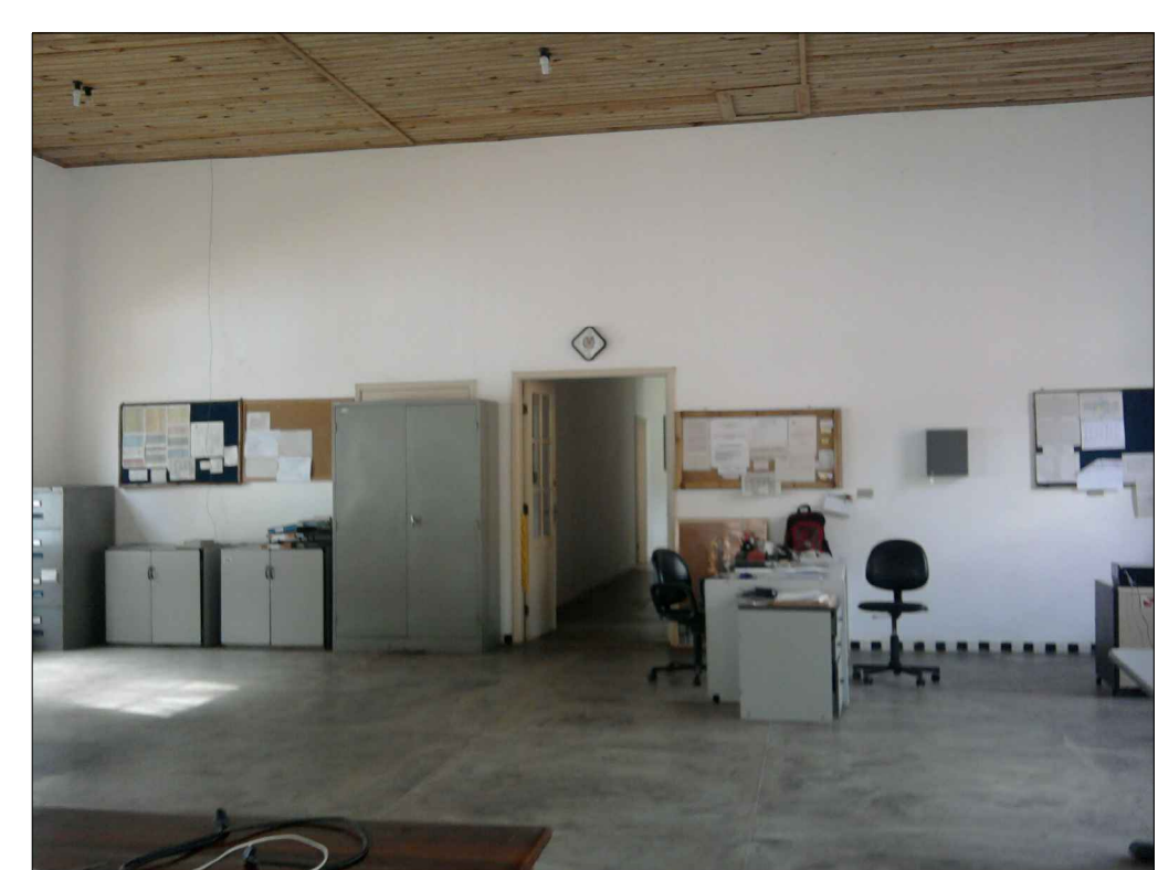
5 TRATAMENTO NO PISO PARA MELHOR CONSERVAÇÃO E PINTURA DAS PAREDES INTERNAS
