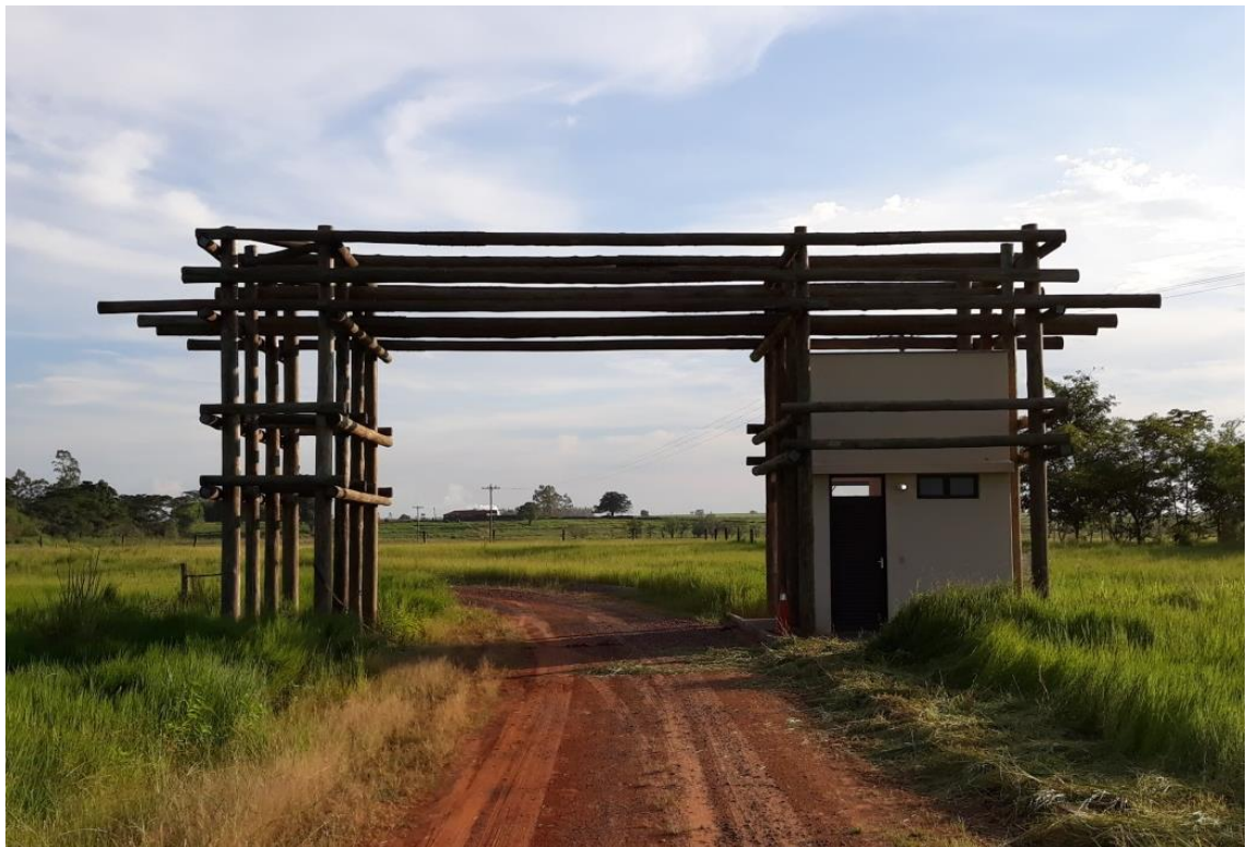
(Pórtico existente no Parque Estadual do Aguapeí)
