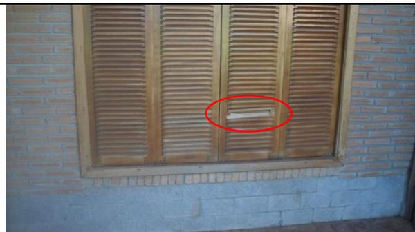
**Figura 4 - Substituir as peças quebradas das venezianas**
