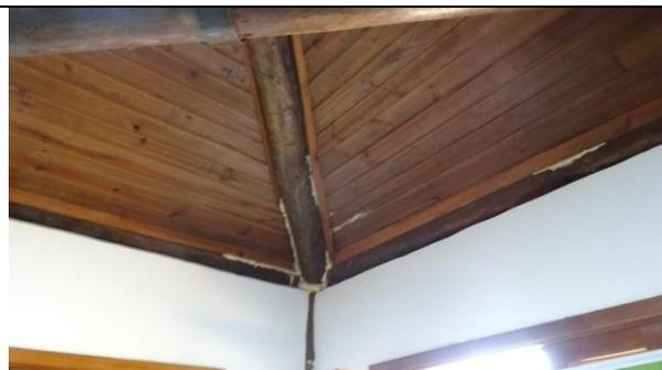
**Figura 8 – Acabamento na espuma expandida, já aplicada.**
