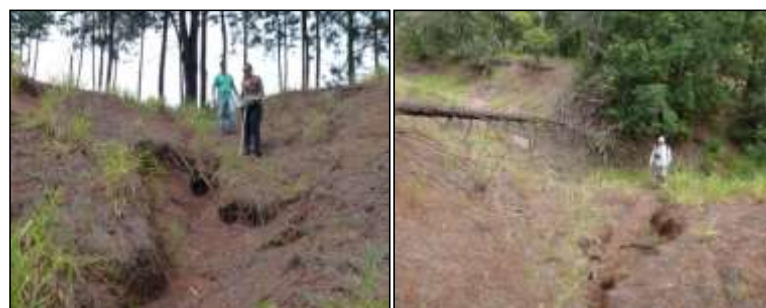
Apêndice 2.3.3U. Processo avançado de erosão pluvial dentro da Estação Experimental.
