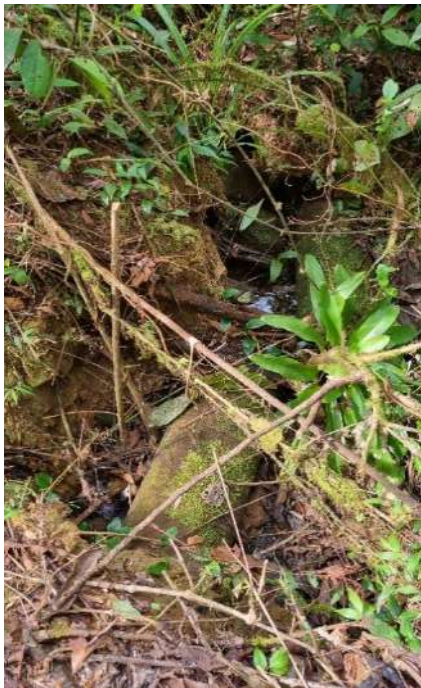
Figura 4. Manilha antiga em curso d'água na trilha existente no interior da RPPN, indicando a presença de estrada antiga.
