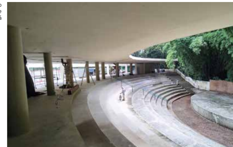
Obra de revitalização da marquise do Parque Estadual do Jaraguá
