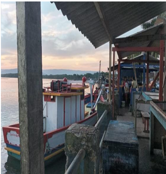
Figura 13 - Pier de desembarque (localizado em frente ao ponto de recebimento de resíduos).
