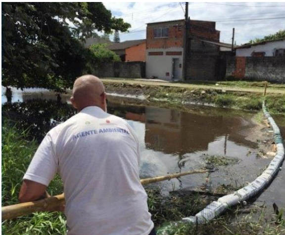
Figura 29 - Instalação de ecobarreira no Rio Campininha, Itanhaém
