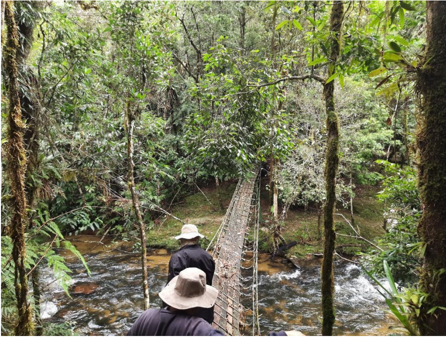
Foto 3 - Ponte pênsil sobre o rio, danificada pela enchente
