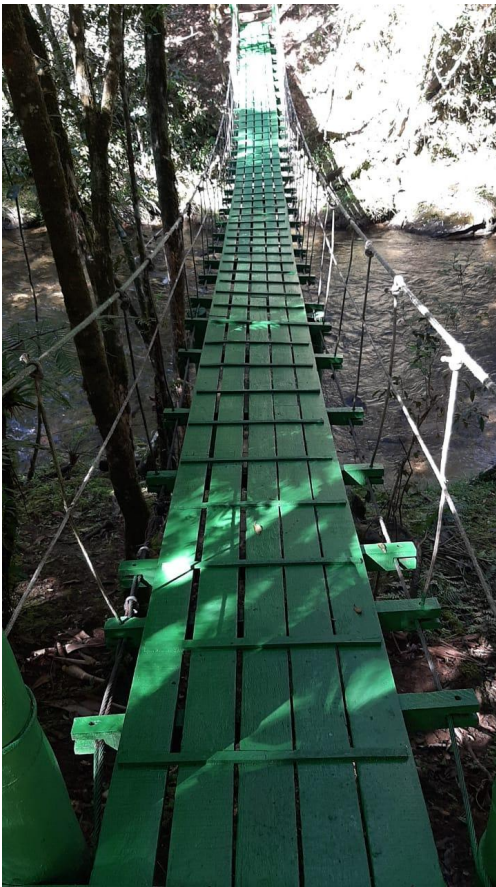
Foto 4 - Ponte pênsil após reparo feito pelos funcionários da Acorb
