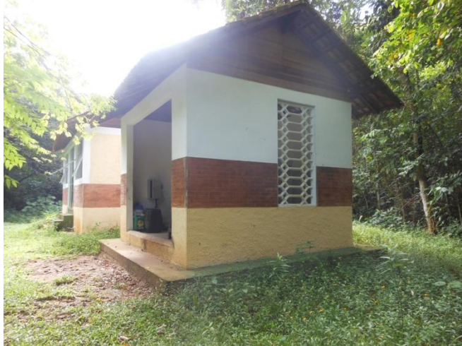
Figura 24: FIM - Local de instalação do grupo de gerador
