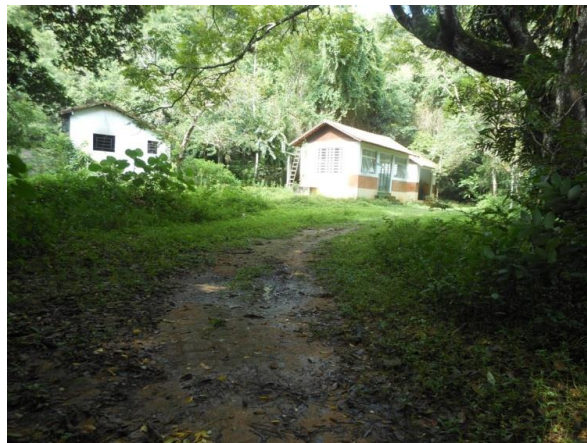
Figuras 22 e 23: Caminho até o local de instalação do grupo de gerador
