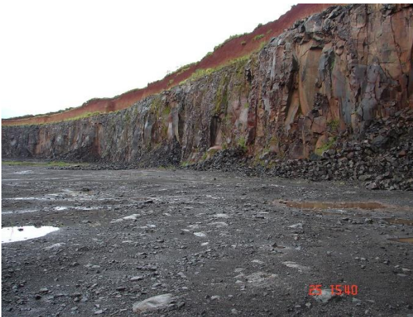
Figura 3a. Vista geral da pedreira nº3, denotando similaridade com as outras pedreiras, capeamento espesso de solo. Esta pedreira no dia da visita, 25/01/2006, encontrava-se momentaneamente paralísada.
