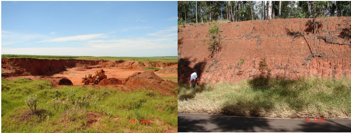
Figura 4a. Área de empréstimo, com retirada de material arenoso para uso em pavimentação de estrada, de cor vermelho amarelo, provavelmente integrante da Aloformação Paranavaí, próximo a Quatá, SP.
