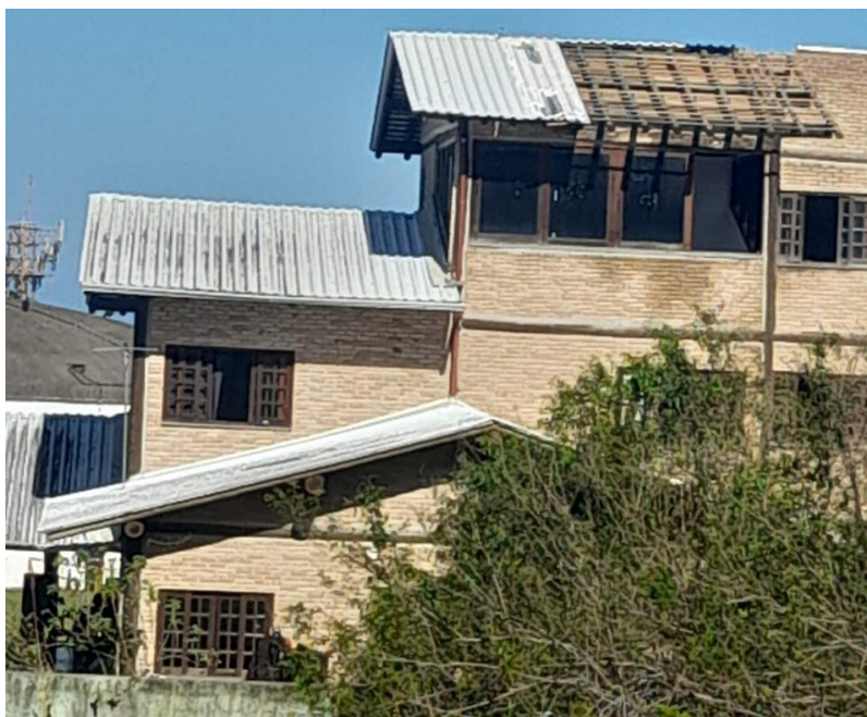
Foto 1: Elevação A - Indicação de trecho de intervenção
