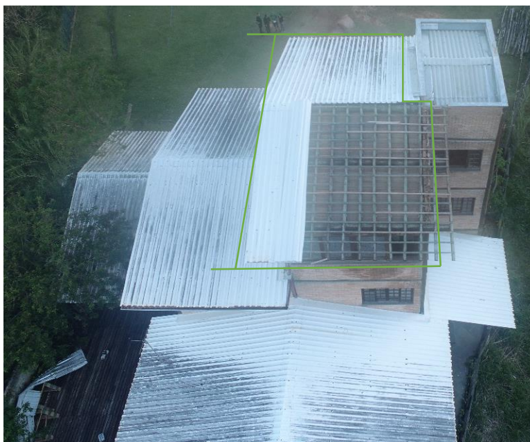
Foto 3: Cobertura - Trecho de intervenção
