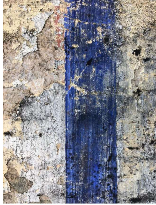
Figura 31 – Ruínas do Presídio Parque Estadual da Ilha Anchieta, 2019. Fonte: Acervo Corsi Arquitetura e Construções LTDA
