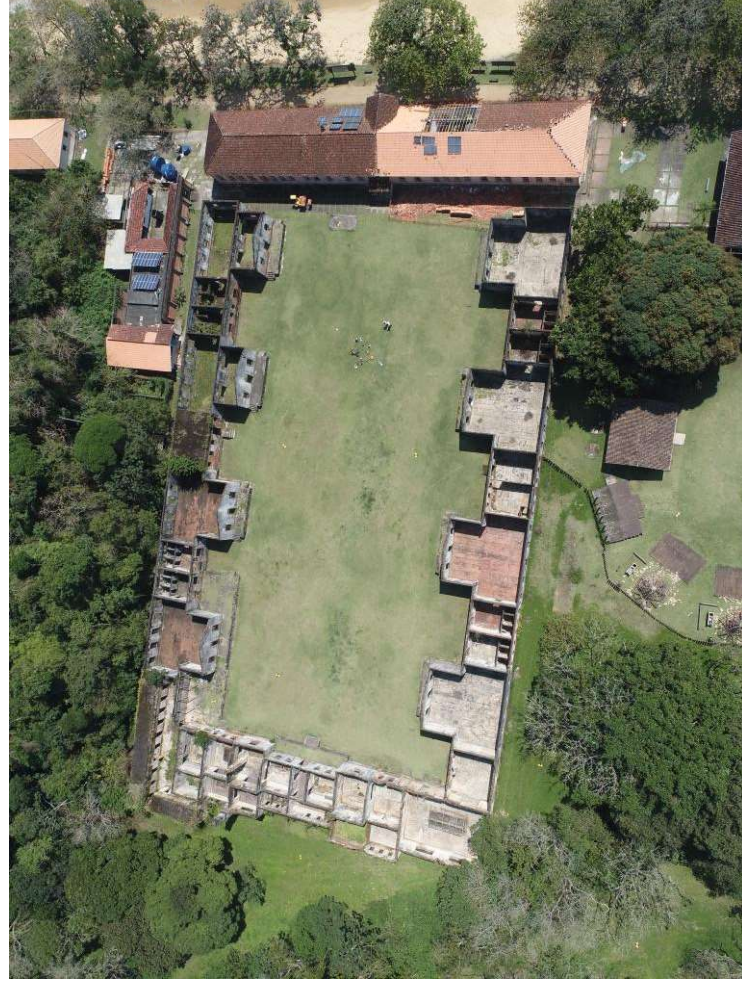
Figura 27 – Ruínas do Presídio Parque Estadual da Ilha Anchieta, 2019.
