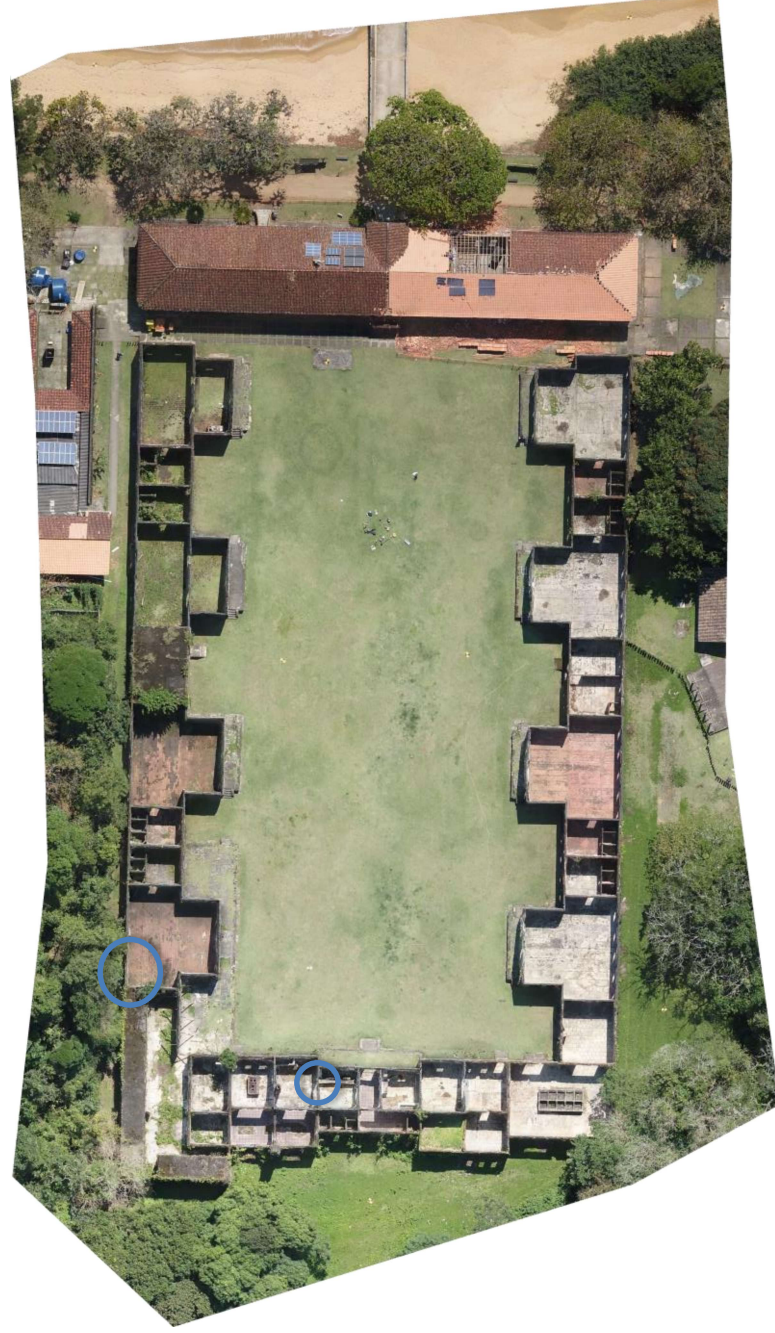
Figura 02. Pontos onde ocorreram pequenas intervenções no complexo.
