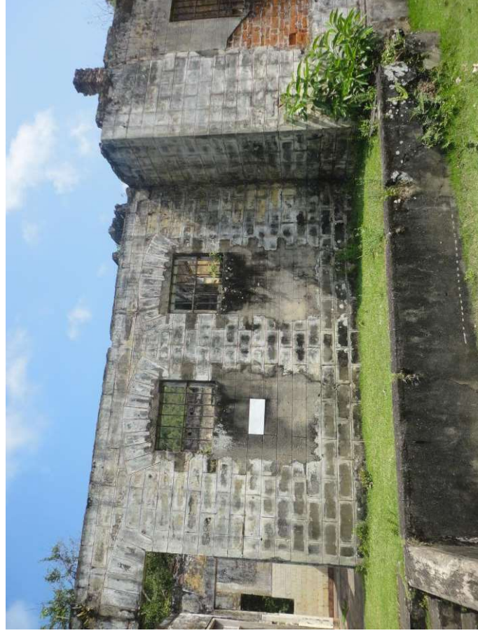
Fonte: Acervo Corsi Arquitetura e Construções, 2019.
