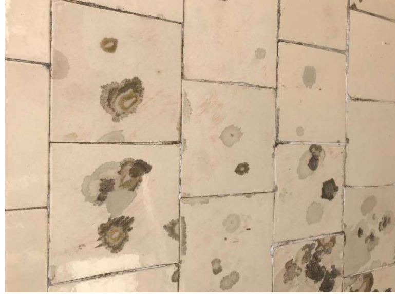
Figura 40 – Ruínas do Presídio Parque Estadual da Ilha Anchieta, 2019. Fonte: Acervo Corsi Arquitetura e Construções LTDA
