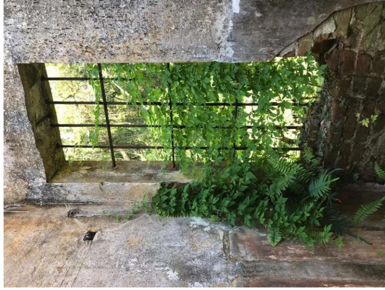
Figura 43 – Ruínas do Presídio Parque Estadual da Ilha Anchieta, 2019. Fonte: Acervo Corsi Arquitetura e Construções LTDA
