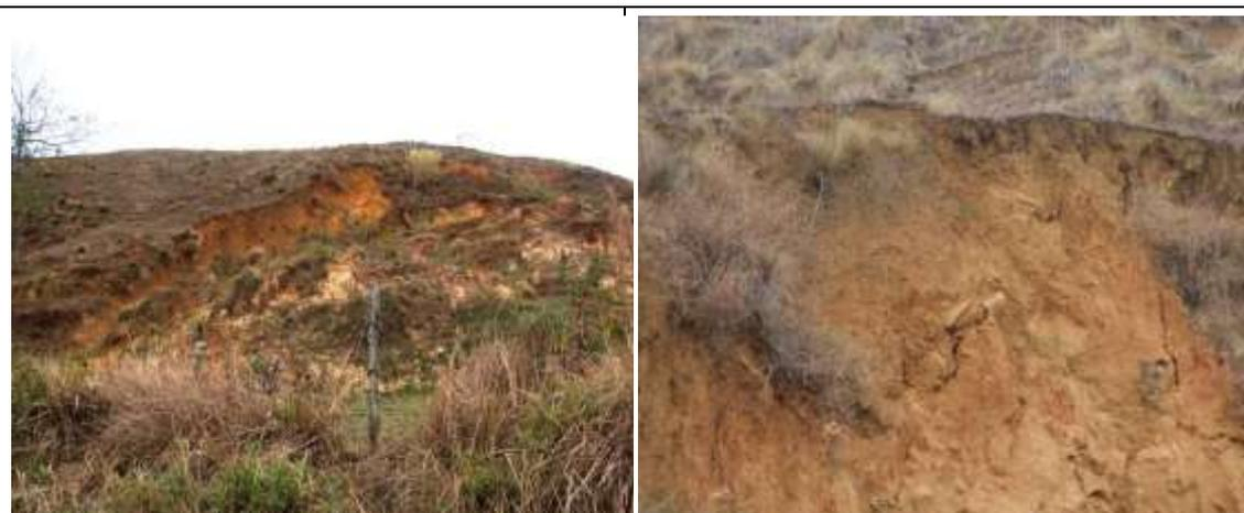
Fotos 57 e 58—Ocorrência de escorregamentos e processos de erosão laminar e em sulco freqüentes e de média a alta intensidade e a presença de depósitos constituídos por blocos e fragmentos de rocha em matriz argilo arenosa rica em grânulos de quartzo, são as características que conferem aos Terrenos Detríticos Coluviais Sensibilidade Geoambiental - Muito Alta.
