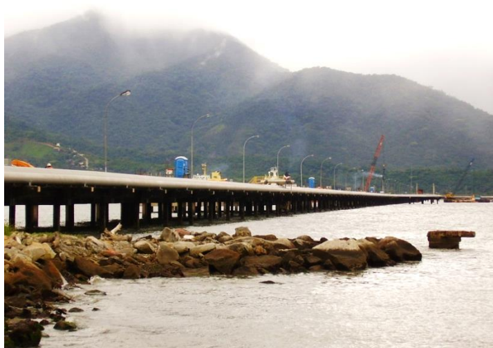
Figura 2. 3. 2 – 5 – Píer do TASSE localizado no Canal de São Sebastião.
