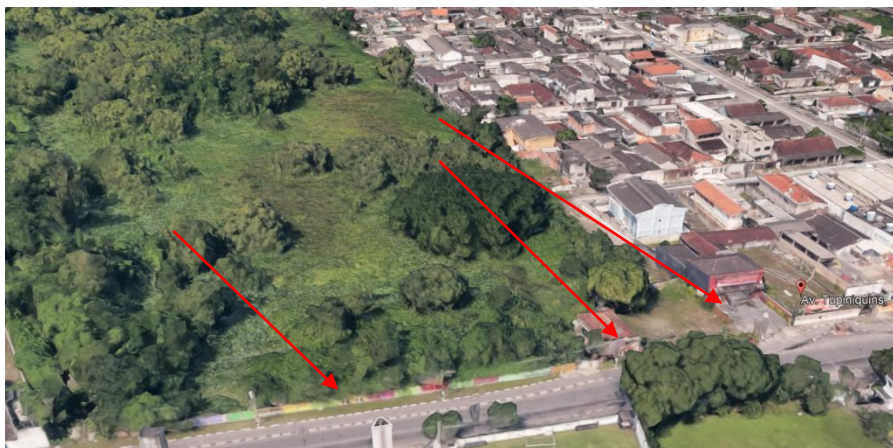
Figura 1– visão geral do passeio e muro do PE Xixová-Japuí
