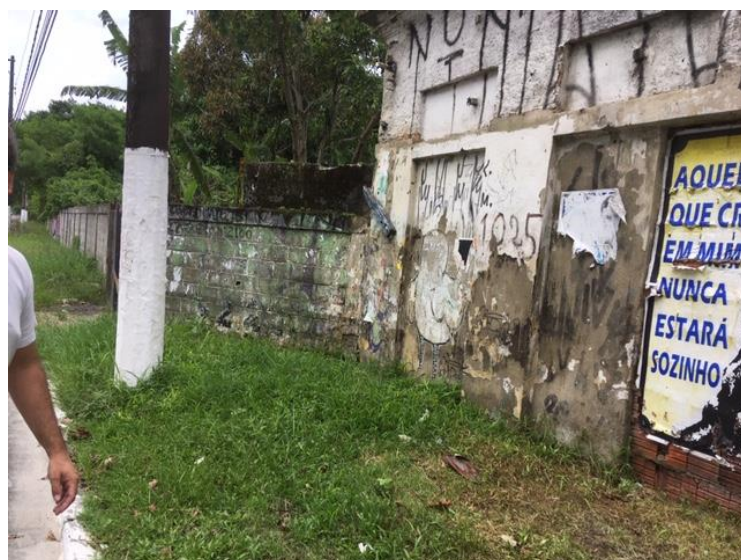
Foto 02 – Muro a ser construído após a demolição da fachada existente
