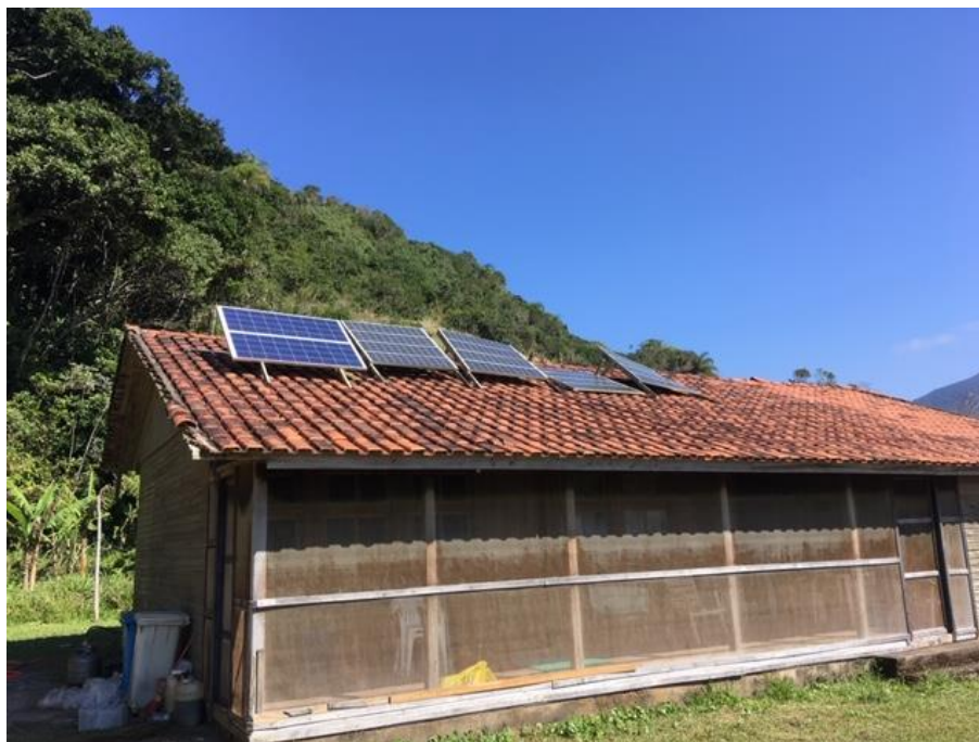
Foto 1 - Vista da edificação da Base Grajauna
