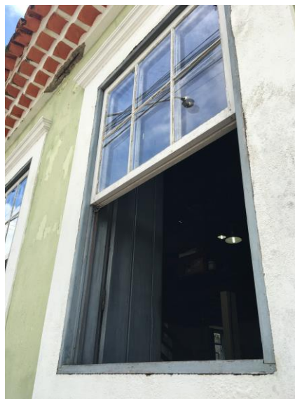
Figura 8 Reparo de Janelas
