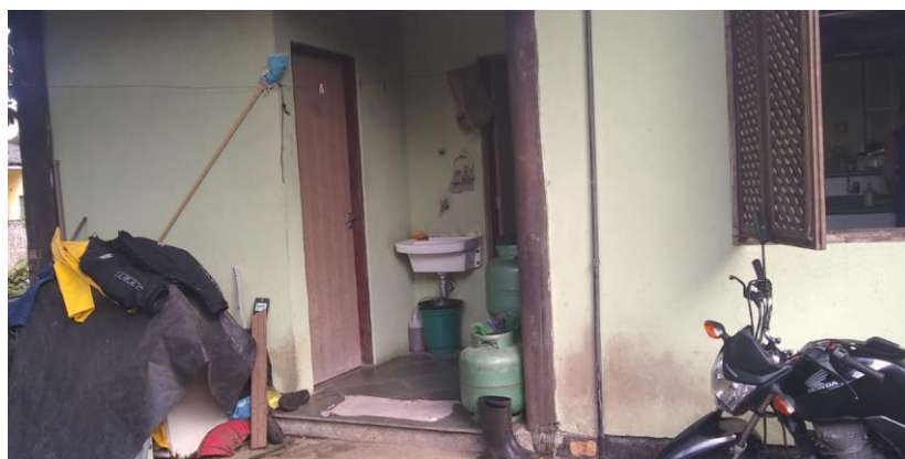
Figura 11 Sanitário a ser adaptado
