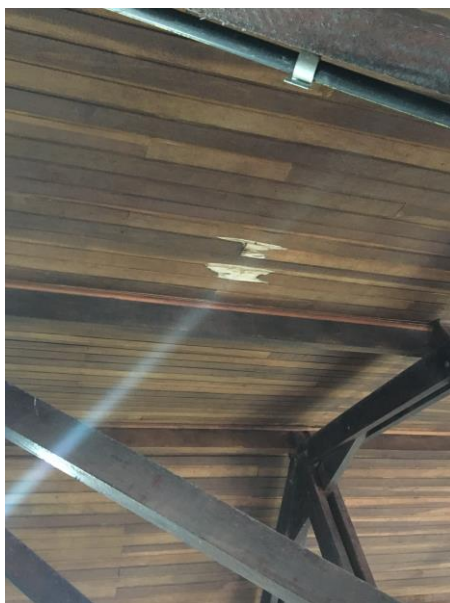
Figura 2 Os trechos de forro reformados deverão ter seus trechos antigos devidamente retirados
