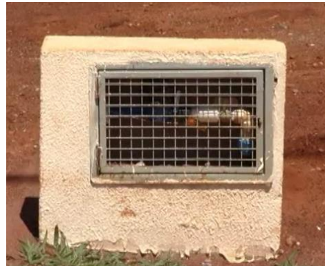
Figura 5 – Exemplo de entrada de água com medido e proteção mecânica
