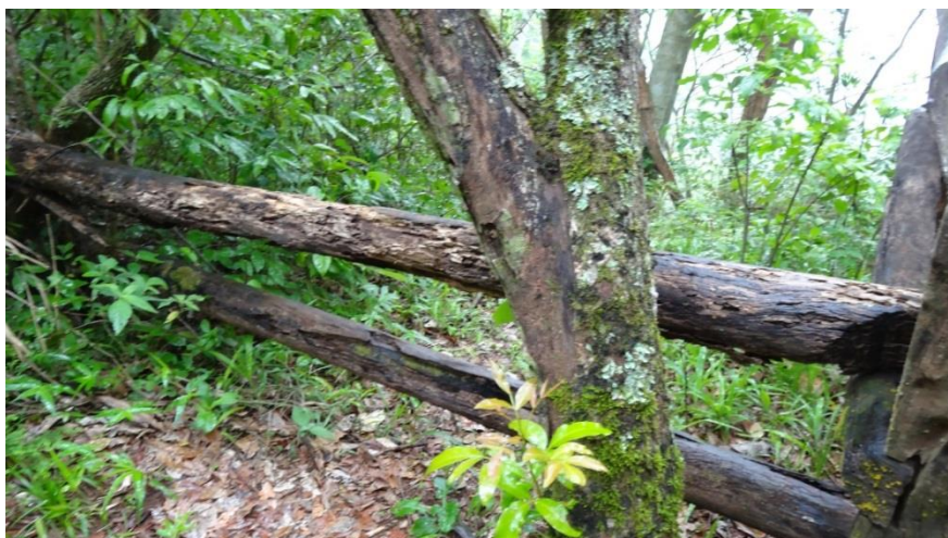
Figura 10: Corrimão deteriorado
