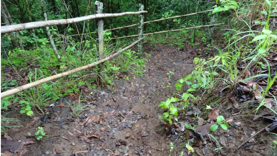
Figura 3 – Manutenção da escadaria e guarda-corpo Manutenção de 10 metros de guarda-corpo e 6 metros de degraus.
