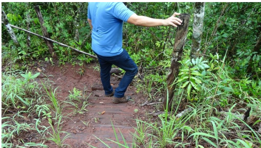
Figura 11: Necessitam de manutenção as escadarias
