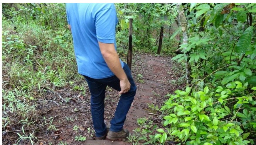
Figura 12: péssimo estado de conservação das escadarias.
