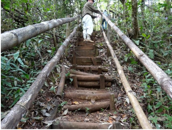
Figura 19 e 20: Lance de subida, manutenção das estruturas. MANUTENÇÃO DE 60 METROS DE GUARDA-CORPO, 60 METROS DE DEGRAUS E INSTALAÇÃO DE PONTE DE PASSAGEM COM 9 X 1 METRO COM CORRIMÃO DE DOIS LADOS.
