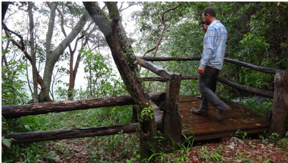
Figura 8: Manutenção em guarda corpo.
