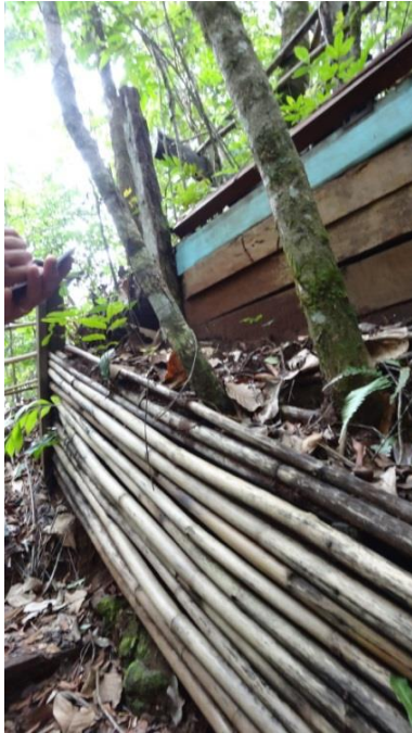
Figura 5 e 6: Estruturas deterioradas de guarda-corpo e escadaria
