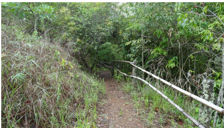
Figura 1 – Manutenção de guarda-corpo
