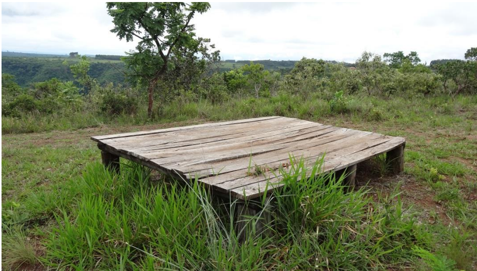
FIGURA 21: DECKS UTILIZADOS COM ELEVADOS DE OBSERVAÇÃO, DETERIORADOS.
