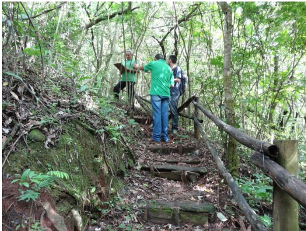
Figura 15 e 16: Segundo lance de descida da escada, deteriorados.
