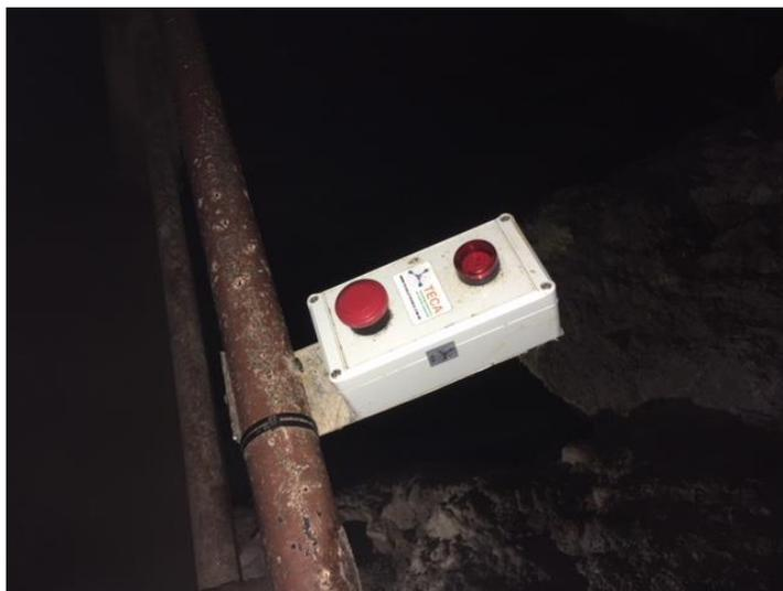
Foto 04 – Dispositivo de acionamento de luzes de emergência sem funcionamento
