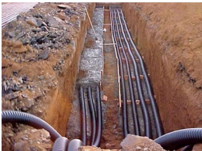
Figura 04 – Exemplo de circuitos elétricos enterrados
