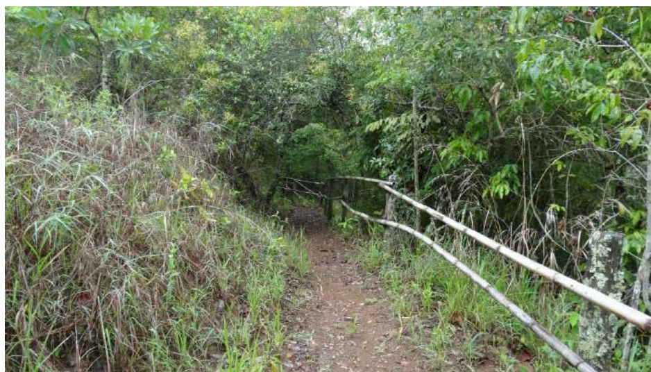
Figura 1 – Manutenção de guarda-corpo
