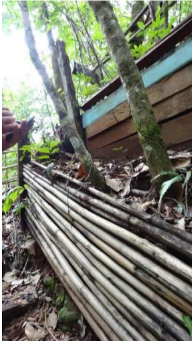
Figura 5 e 6: Estruturas deterioradas de guarda-corpo e escadaria
