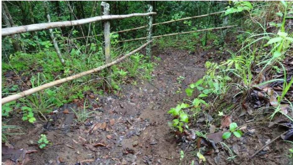
Figura 3 – Manutenção da escadaria e guarda-corpo Manutenção de 10 metros de guarda-corpo e 6 metros de degraus.
