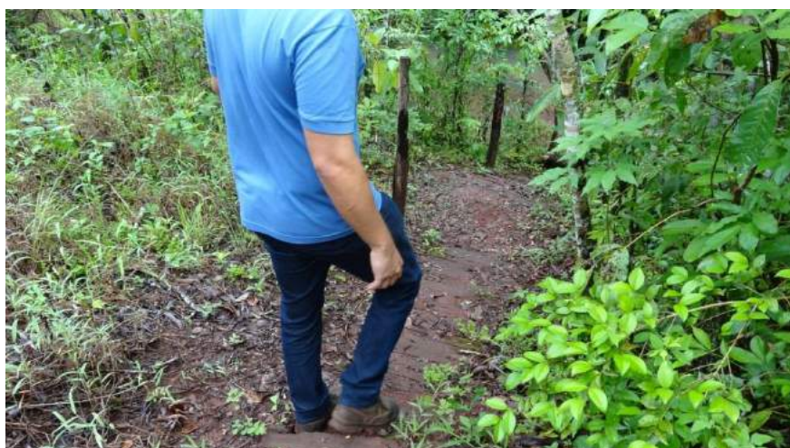
Figura 12: péssimo estado de conservação das escadarias.
