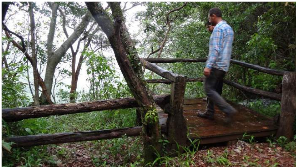
Figura 8: Manutenção em guarda corpo.
