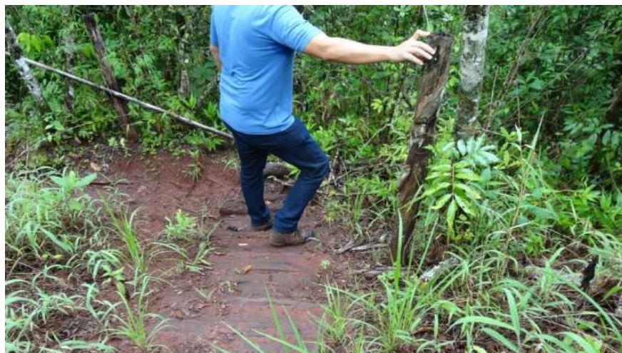
Figura 11: Necessitam de manutenção as escadarias
