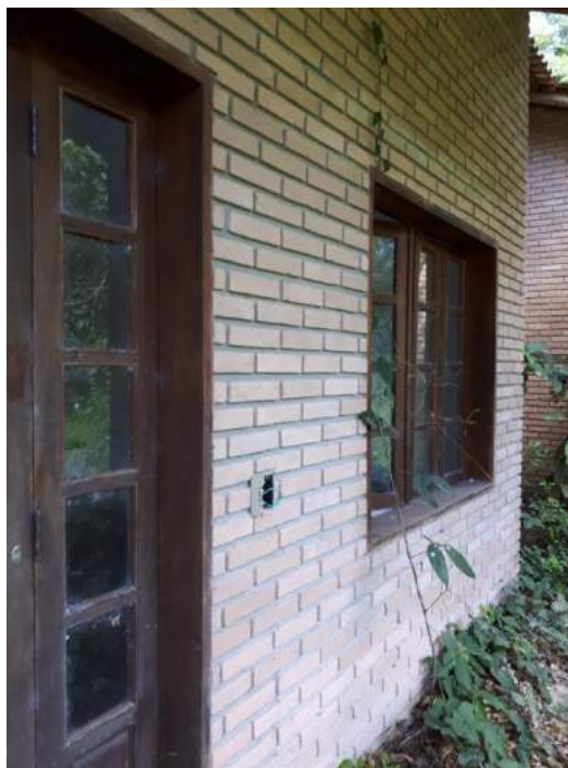
Foto 7 – Vista geral de esquadrias externas
