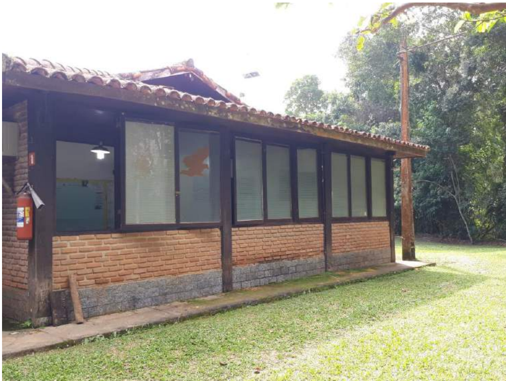
Figura 8 – Foto do trecho da Fachada frontal com revestimento em tijolo maciço laminado
