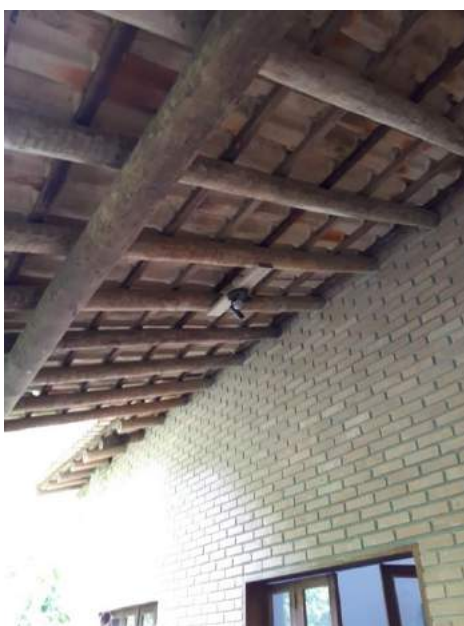
Foto 13 – Vista geral do madeiramento da cobertura
