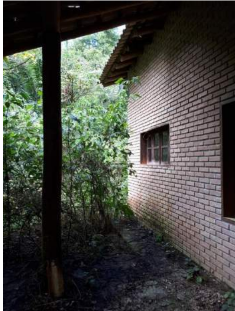
Foto 14 – Vista geral do revestimento da fachada
