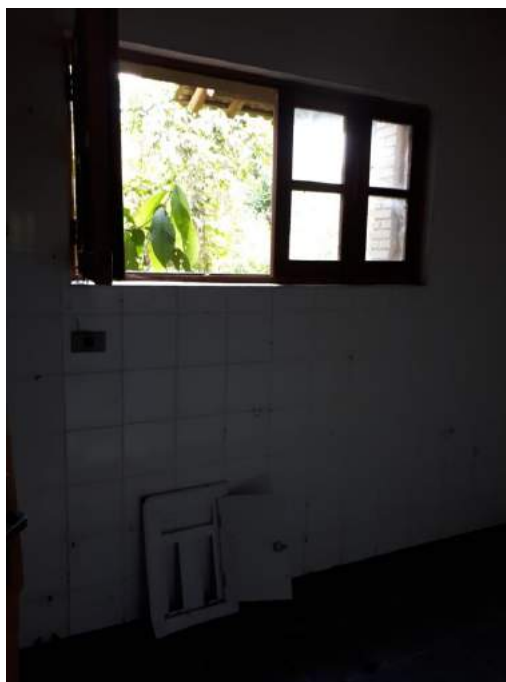
Foto 6 – Vista geral da esquadria
