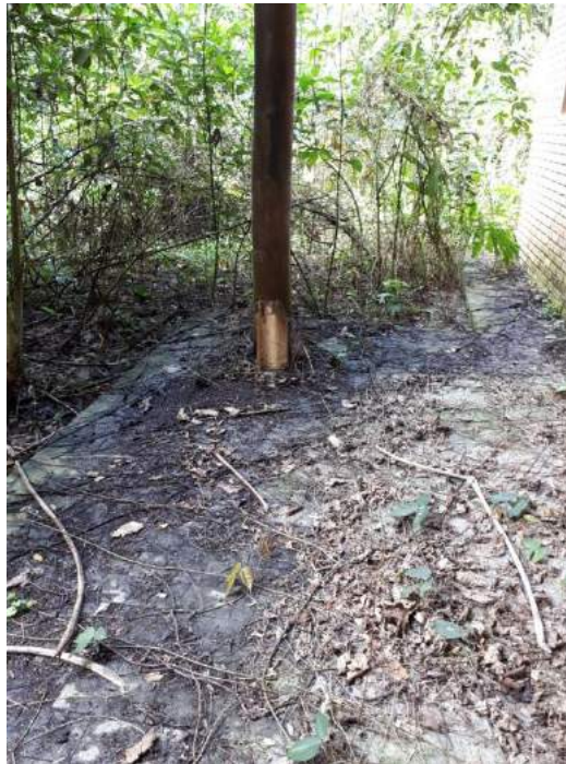
Foto 5 – Piso externo em miracema
