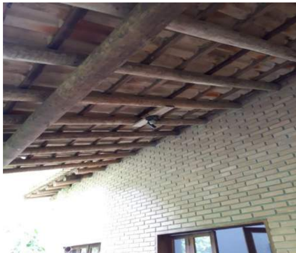
Foto 3 – Cobertura em estrutura de madeira com telhamento cerâmico
