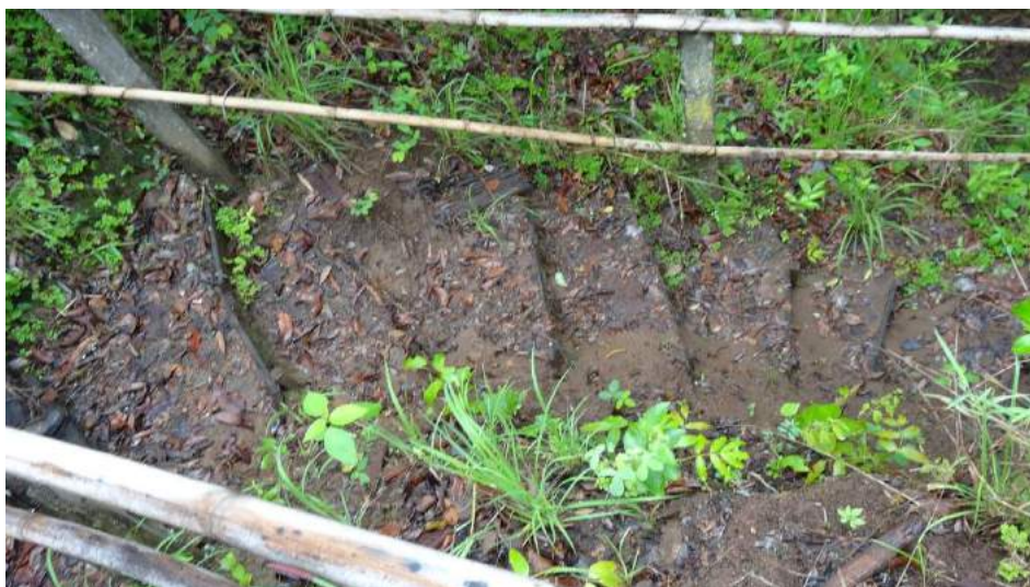
Figura 2 – Necessita de substituição da escadaria
