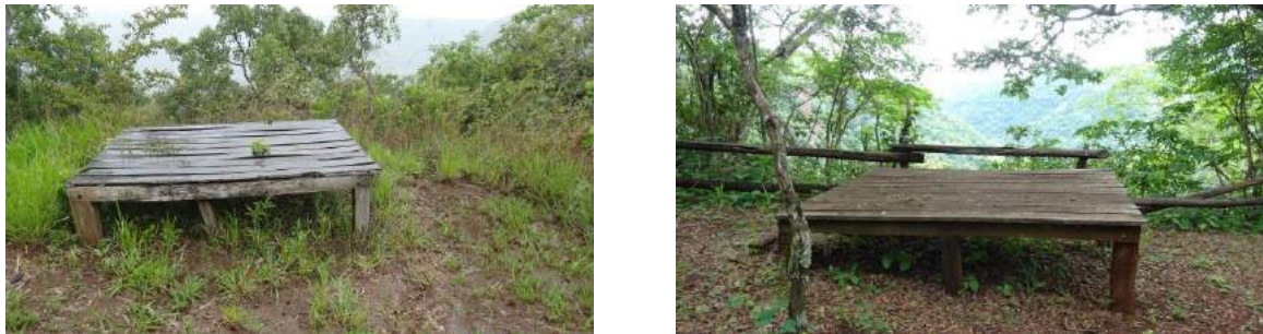
Figura 15 e 19: Decks para manutenção
