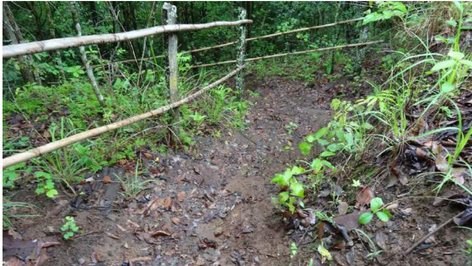
Figura 3 – Manutenção da escadaria e guarda-corpo Manutenção de 10 metros de guarda-corpo e 6 metros de degraus.
