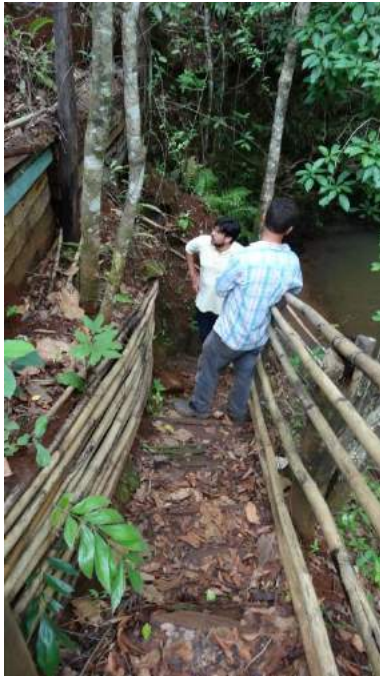
Figura 6 e 7: Muro de contenção com madeiras deterioradas na escada em “S”.
