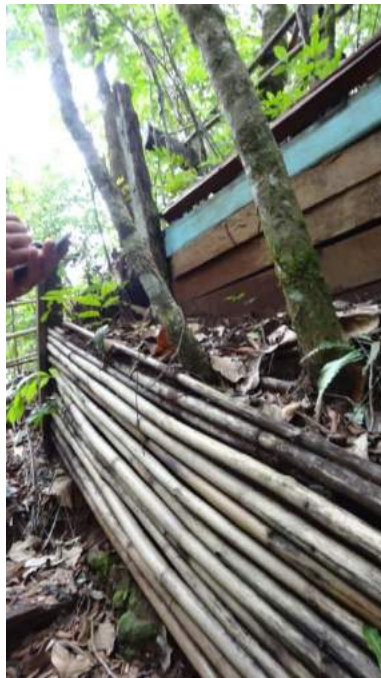
Figura 5 e 6: Estruturas deterioradas de guarda-corpo e escadaria
