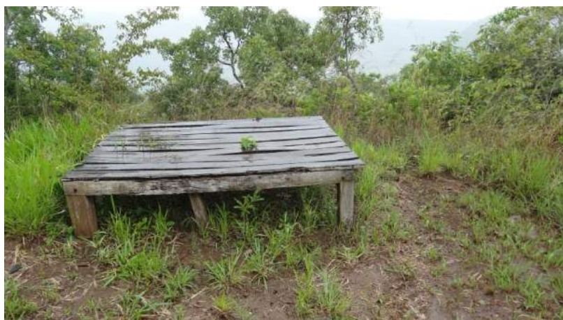
FIGURA 22: DECK DETERIORADO
