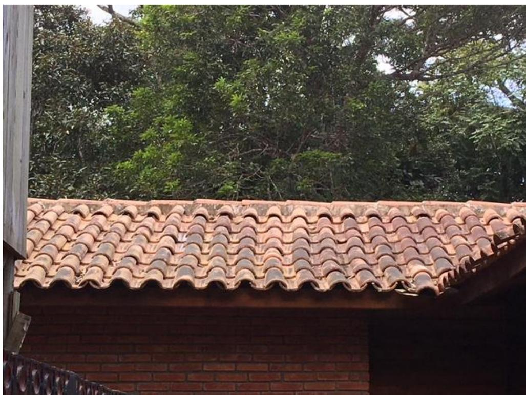
Foto 06 – Condições da cobertura existente. Nota-se o desalinhamento de telhas cerâmicas.
