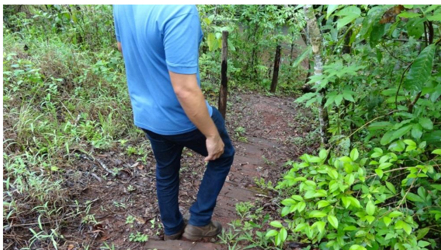
Figura 12: péssimo estado de conservação das escadarias.
