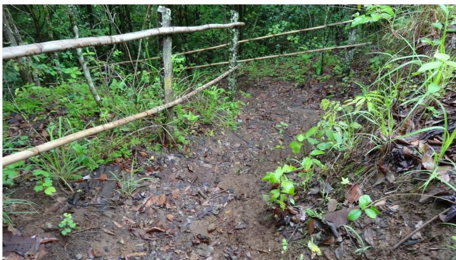
Figura 3 – Manutenção da escadaria e guarda-corpo
