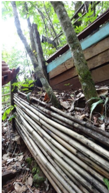
Figura 5 e 6: Estruturas deterioradas de guarda-corpo e escadaria
