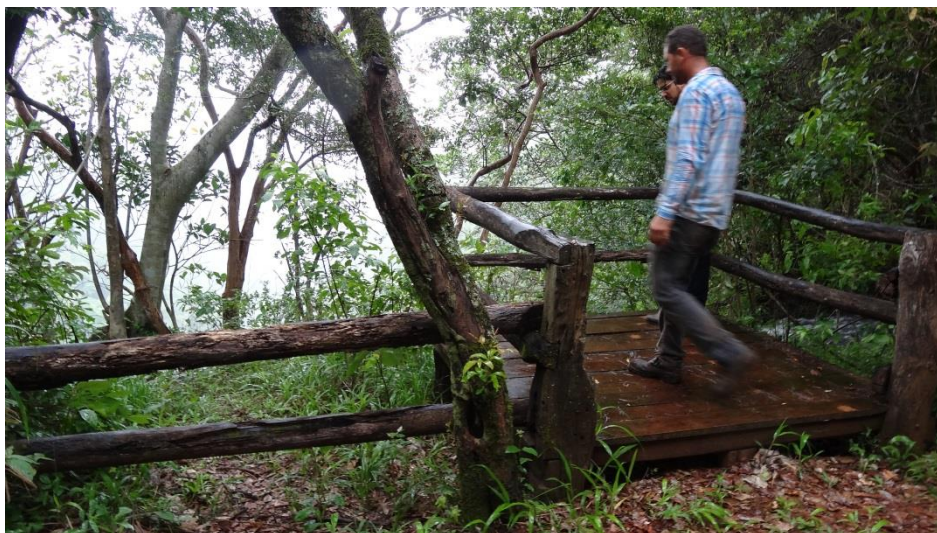
Figura 8: Manutenção em guarda corpo.
