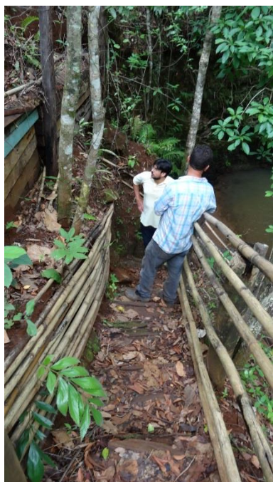
Figura 6 e 7: Muro de contenção com madeiras deterioradas na escada em "S".
