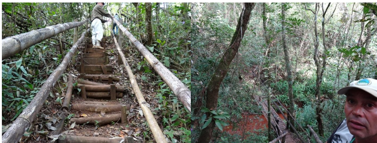
Figura 19 e 20: Lance de subida, manutenção das estruturas.
