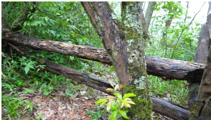
Figura 10: Corrimão deteriorado
