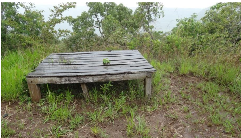
Figura 22: Deck deteriorado
