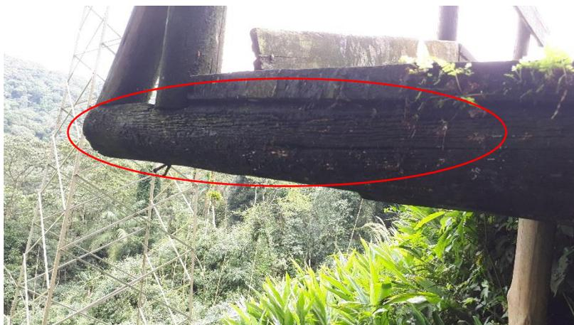
Foto 17 – Processo de deterioração do alburno da vigia já iniciado
