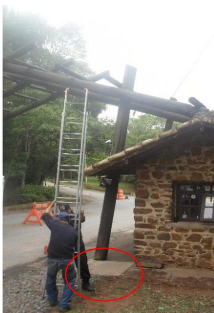
Foto 50 – Base do pilar – demolição de piso para expor da fundação
