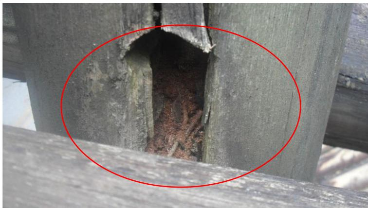
Foto 45 – Recalque na ligação metálica causado pelo apodrecimento do cerne do eucalipto
