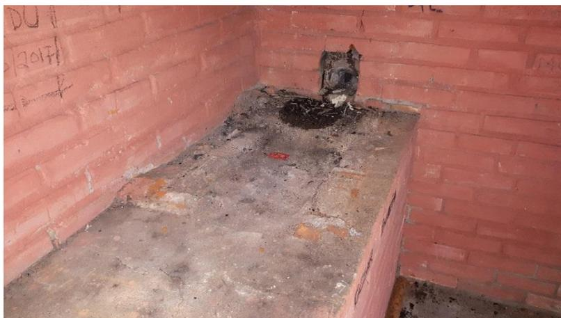
Foto 35 – Fogão a lenha – refazer as paredes com tijolos refratários
