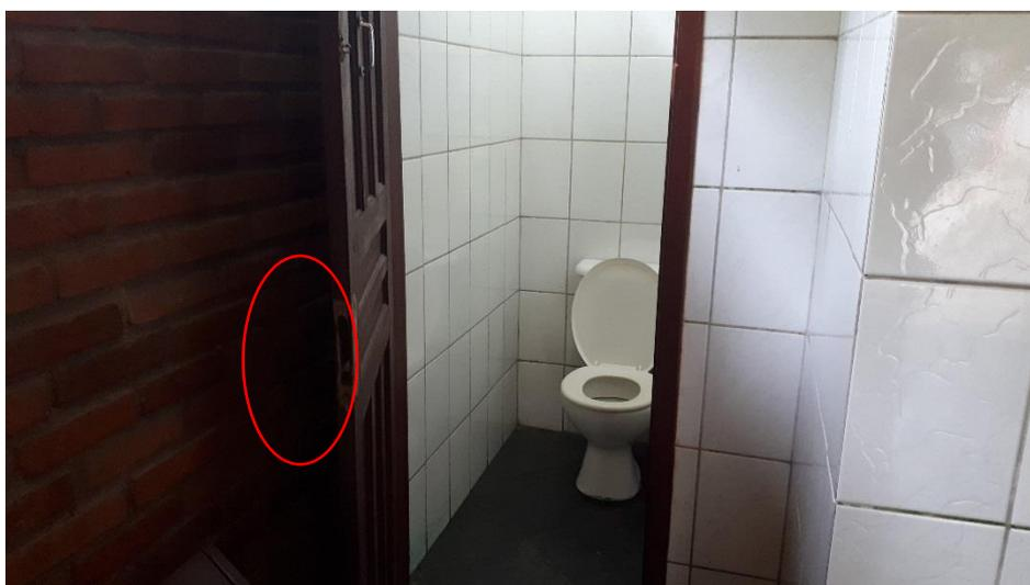
Foto 6 – Falta fechadura nas portas dos boxes
