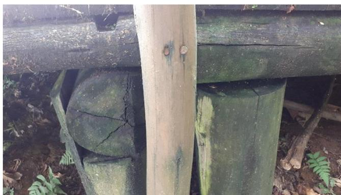
Foto 15 – Revisar as ligações metálicas (pregos, parafusos, porcas e reaperto)
