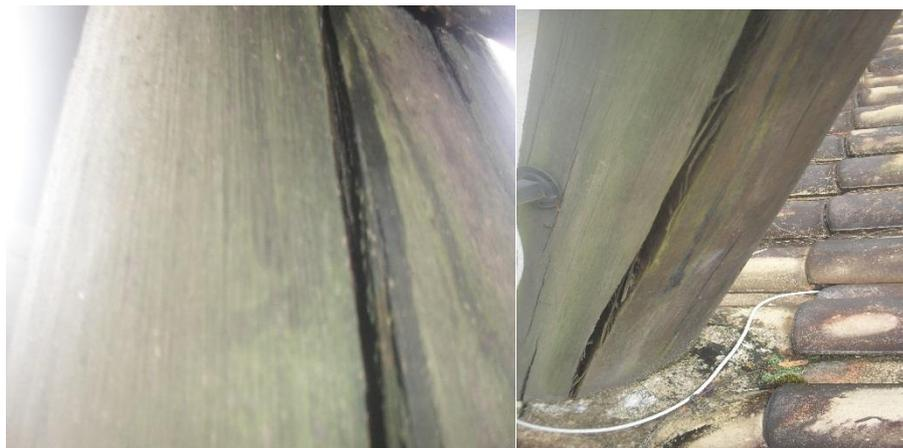
Foto 47 – Retração da madeira causando rachaduras longitudinais
