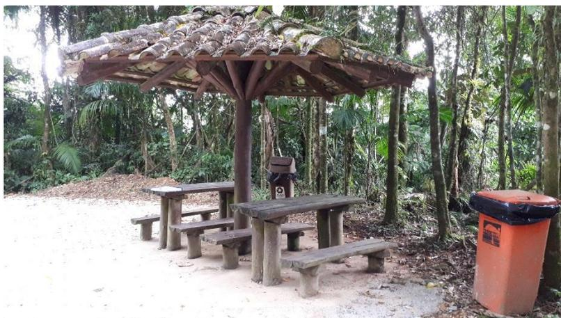
Foto 29 – Retirar as telhas e recoloca-las após tratamento com resina
