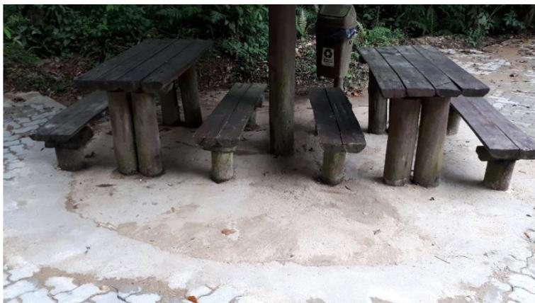
Foto 28 – Posição das mesas e bancos errada e piso executado sem critérios
