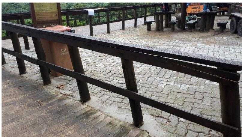
Foto 18 – Peças deterioradas e soltas oferecendo risco ao usuário
