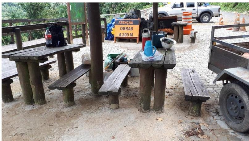
Foto 22 – O novo piso alterou a altura dos bancos e mesas e comprometeu a estética e simetria.
