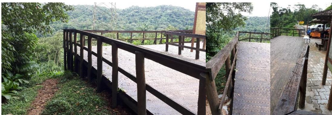
Fotos 12, 13 e 14 – Guarda corpo deformado e assoalho impróprio para área externa
