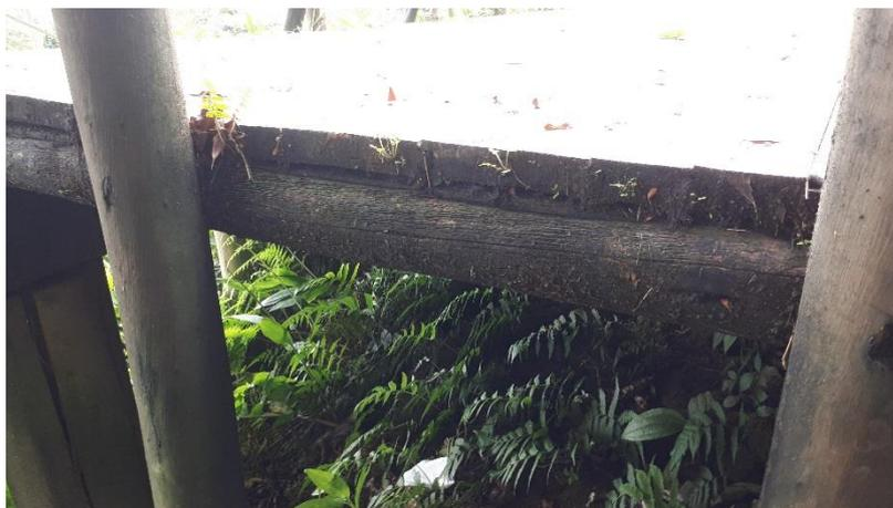
Foto 16 – Processo de deterioração do alburno da vigia já iniciado
