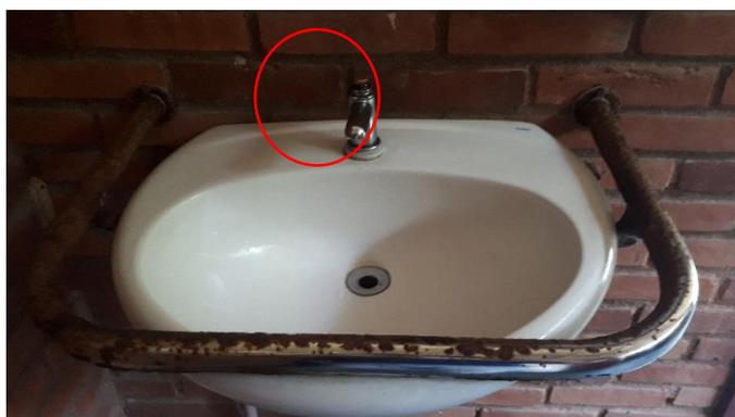
Foto 10 – Substituir as torneiras do lavatório e barra de apoio por inox
