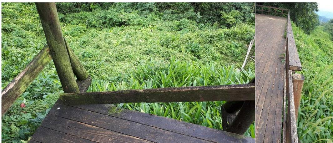
Fotos 19 e 20 – Ausências de peças no guarda corpo com risco de queda dos usuários
