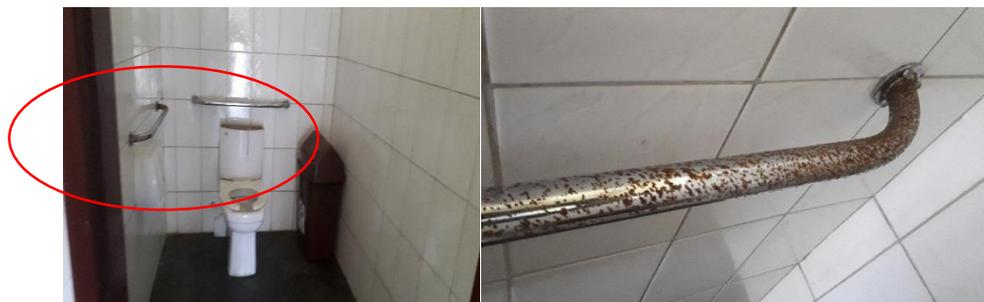
Fotos 7 e 8 – Substituir sistema de acionamento na caixa acoplada e barras de apoio por inox
