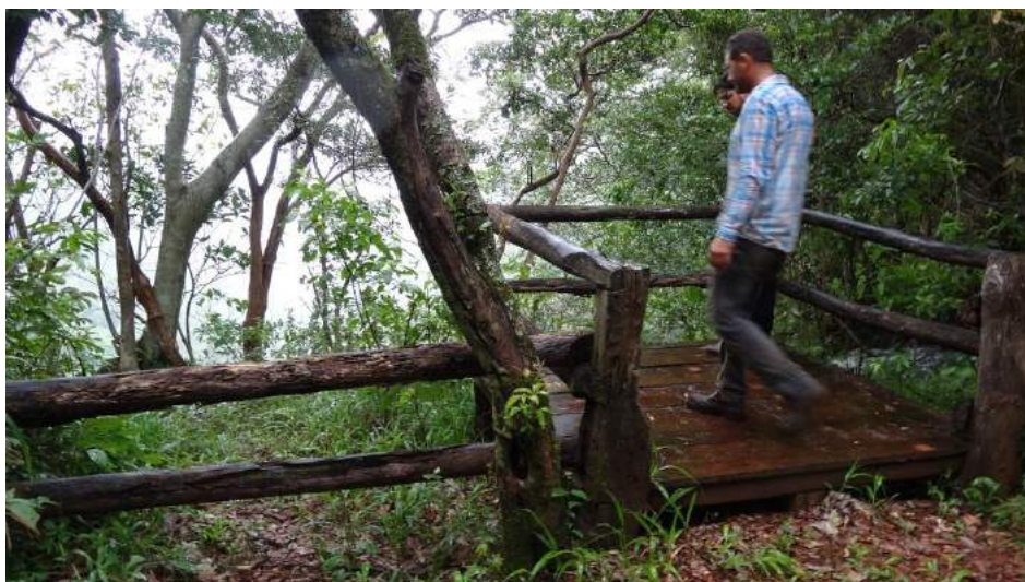
Figura 8: Manutenção em guarda corpo.
