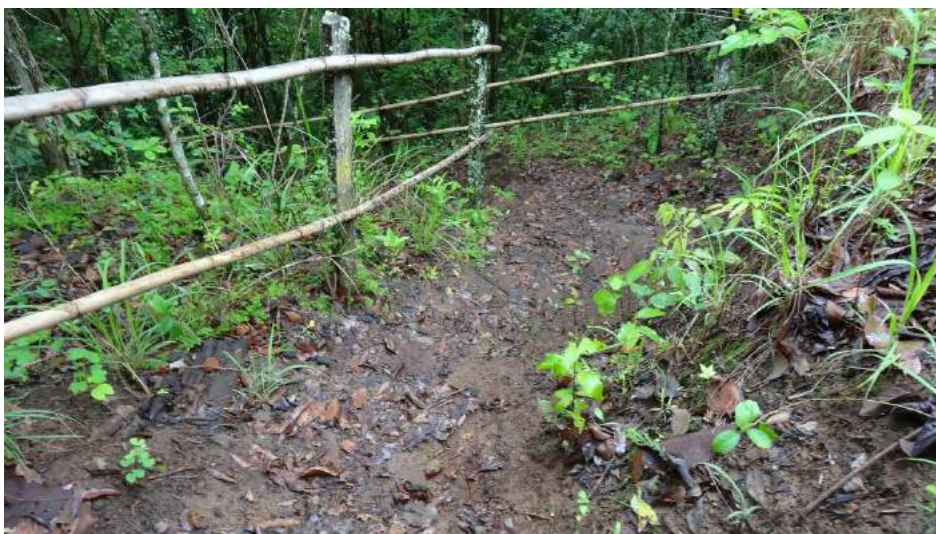
Figura 3 – Manutenção da escadaria e guarda-corpo
