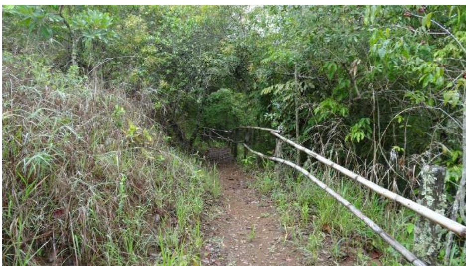
Figura 1 – Manutenção de guarda-corpo
