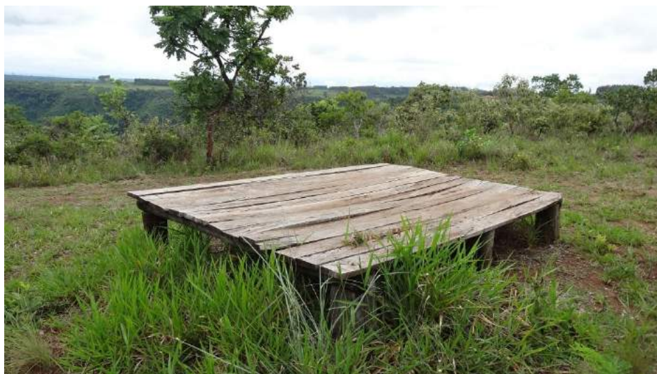
Figura 21: Decks utilizados com elevados de observação, deteriorados.
