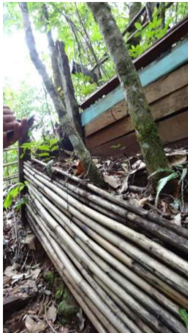
Figura 5 e 6: Estruturas deterioradas de guarda-corpo e escadaria
