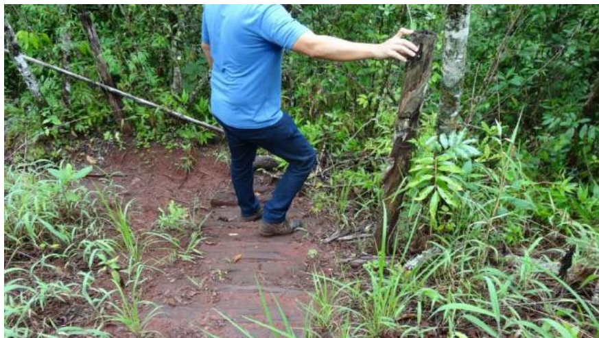
Figura 11: Necessitam de manutenção as escadarias
