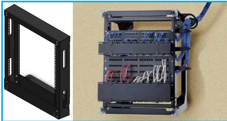
Figura 4 - Rack de parede aberto.
