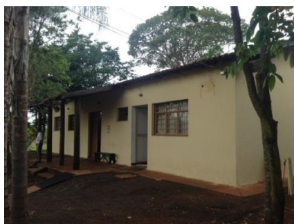
Figura 04 – Edificação a ser Readequada
