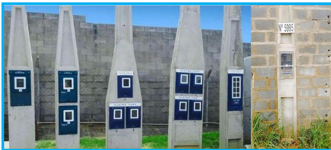
Figura 6 – Padrão de entrada conforme normas da Elektro.
