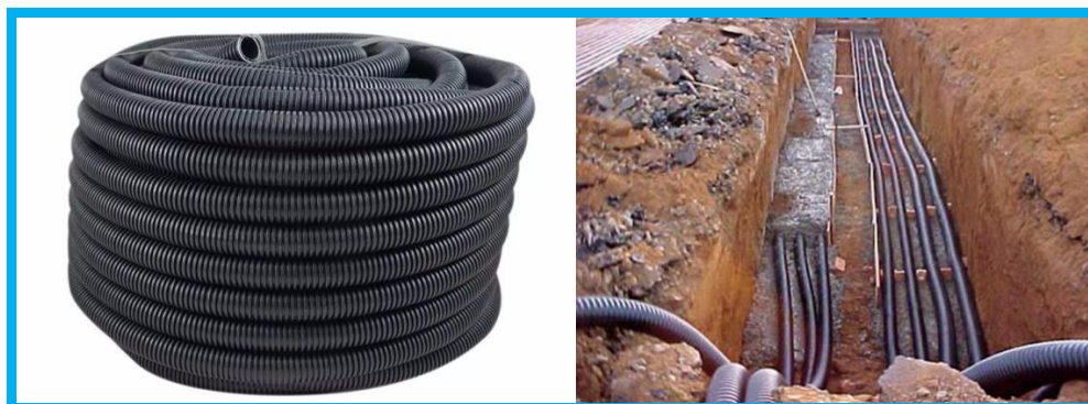
Figura 8 - Eletroduto em PEAD.
