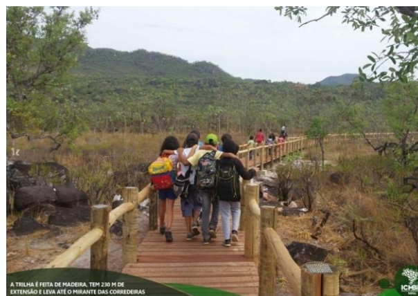
Figura 3 - VISTA DO PISO DA PASSARELA COM MADEIRAS SERRADAS E GUARDA CORPO
