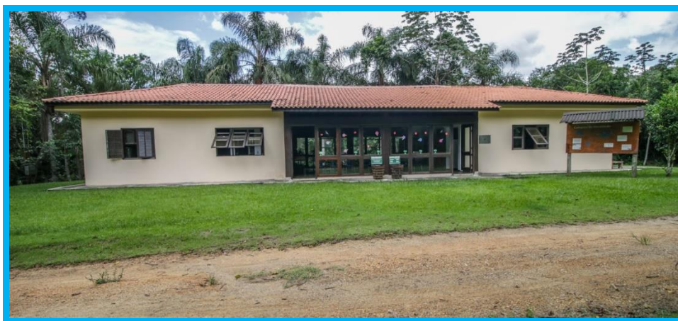
Figura 2 – Fachada da sede da Unidade.
