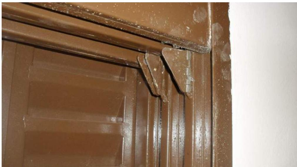
Foto 26 – Borboleta precisando de ajuste ou substituição
