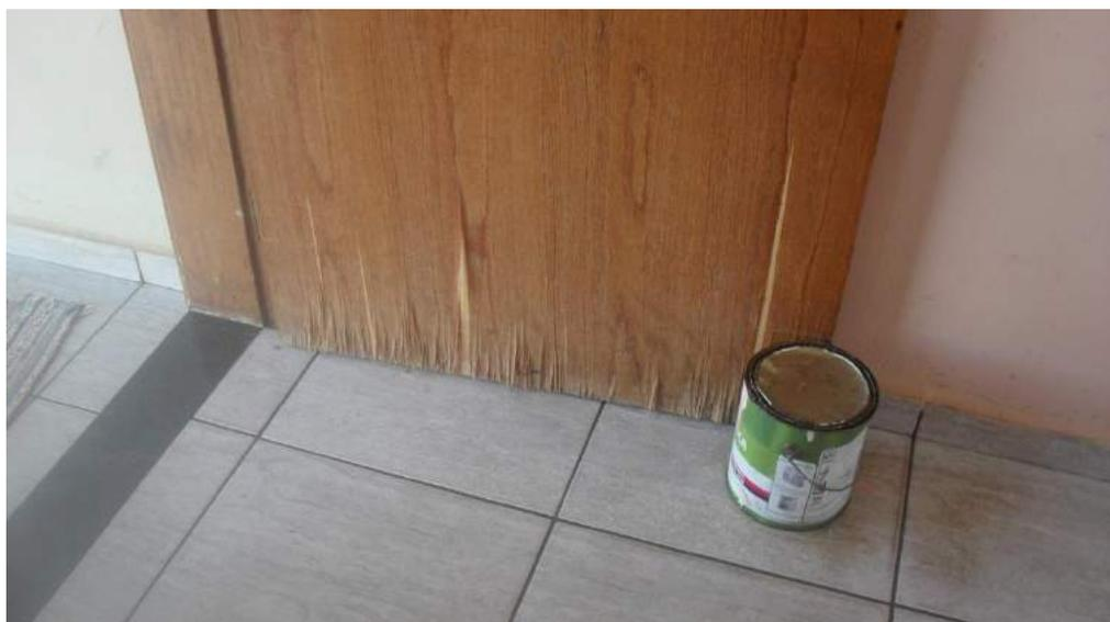
Foto 22 – Porta de entrada com a lâmina de revestimento descolando
