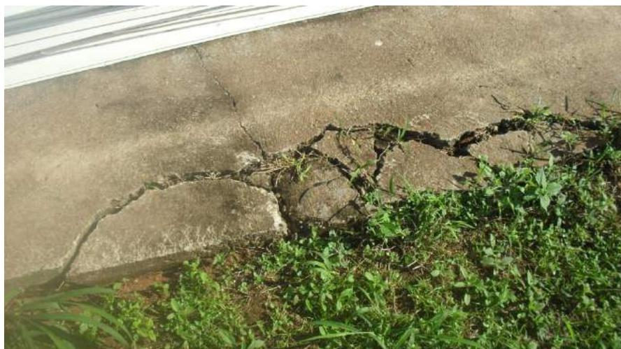
Foto 43 – Quebra causada pela roda de veículo
