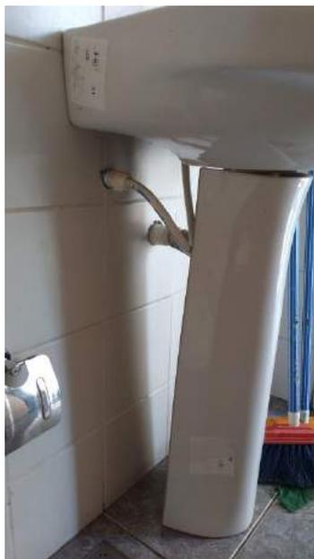
Foto 80 - Sifão retorcido, trincado e com vazamento.
