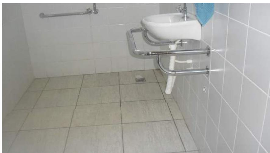
Foto 37 – O Sifão corrugado (longo) corrige o erro da altura da tubulação
