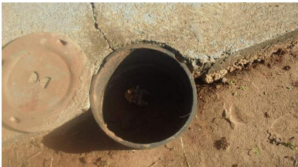
Foto 20 – Haste de aterramento – Não localizada a descida
