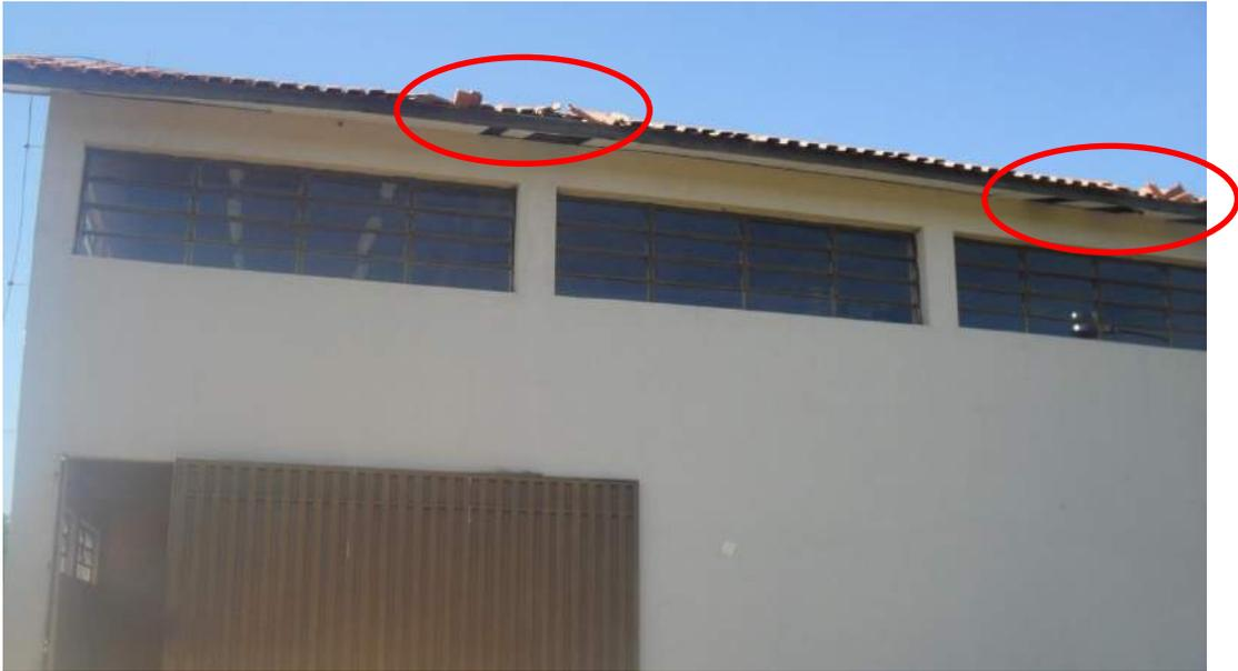
Foto 77 – Refazer forro, ajustar ou substituir telhas
