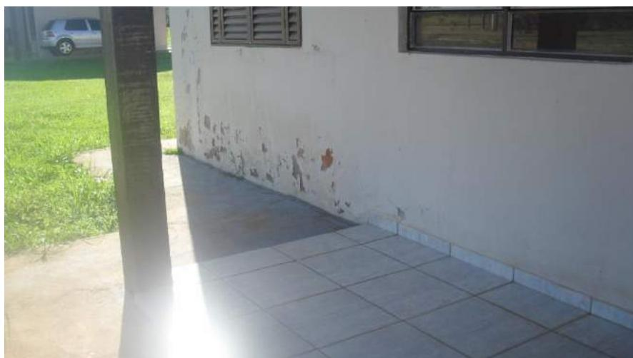
Foto 46 – Deterioração da pintura no trecho próximo da calçada
