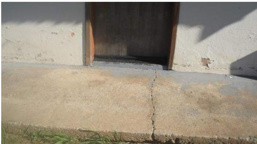
Foto 42 – Fissura causada por falta de junta de dilatação
