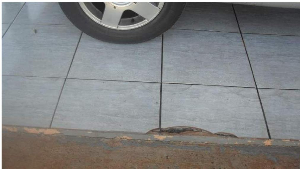
Foto 18 – Abrigo de veículos com cerâmicas soltas e quebradas
