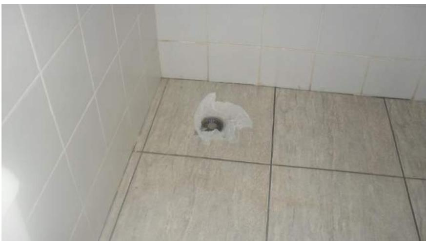
Foto 39 – Paliativo para impedir desprendimento de gases
