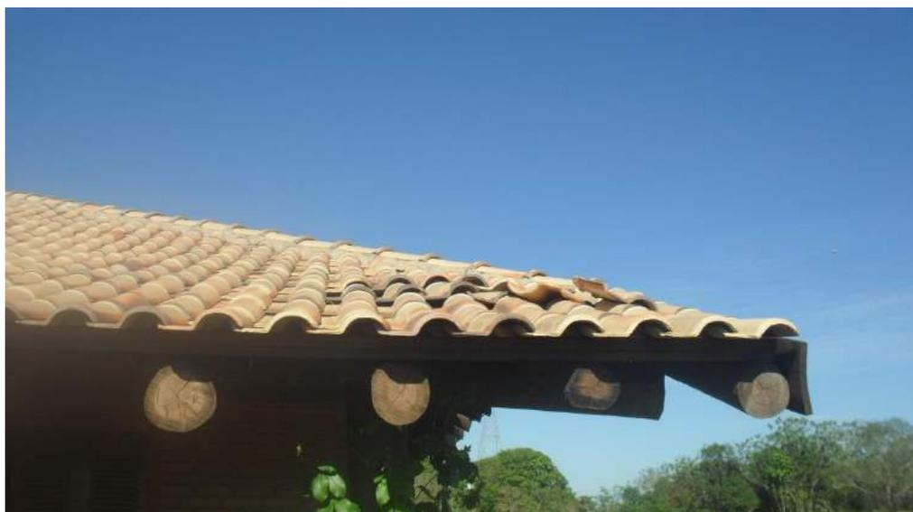
Foto 61 – Realinhamento / Substituição de telhas e cumeeiras
