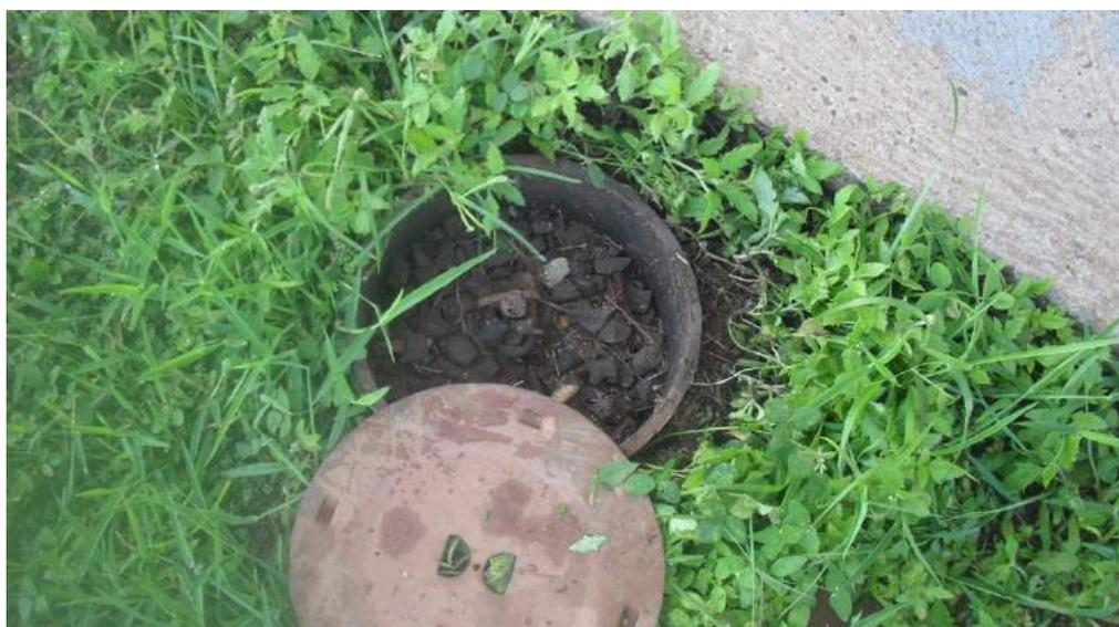
Foto 19 – Haste de aterramento – Não localizada a descida
