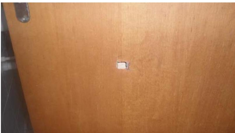
Foto 23 – Porta do sanitário com furo causado por choque mecânico
