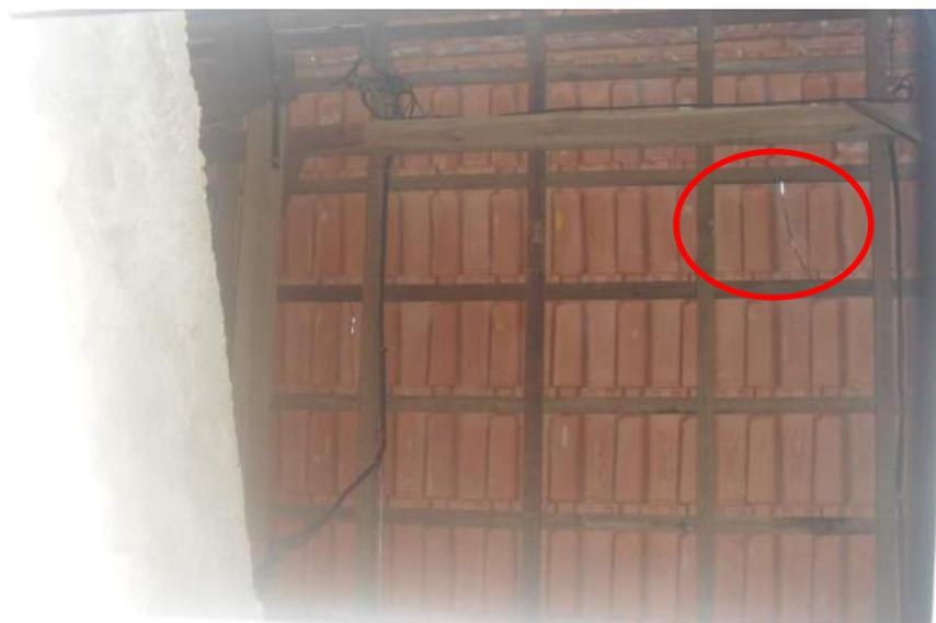
Foto 16 – Telha quebrada a ser substituída
