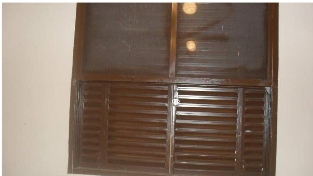
Foto 27 – As guilhotinas emperram, necessitam de ajustes
