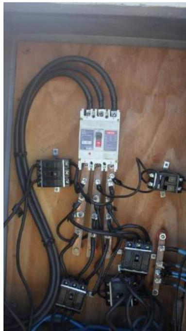
Foto 65 – Quadro Externo de Distribuição de Energia
