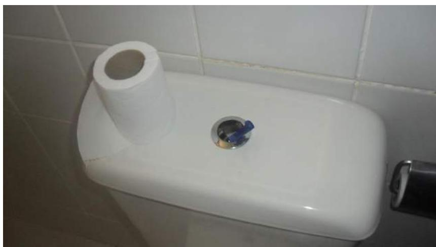
Foto 41 – Válvula de acionamento quebrada
