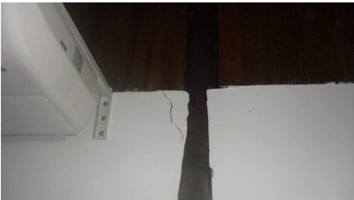
Foto 55 – Desprendimento da alvenaria entre o pilar de madeira e o esforço causado pelo Split
