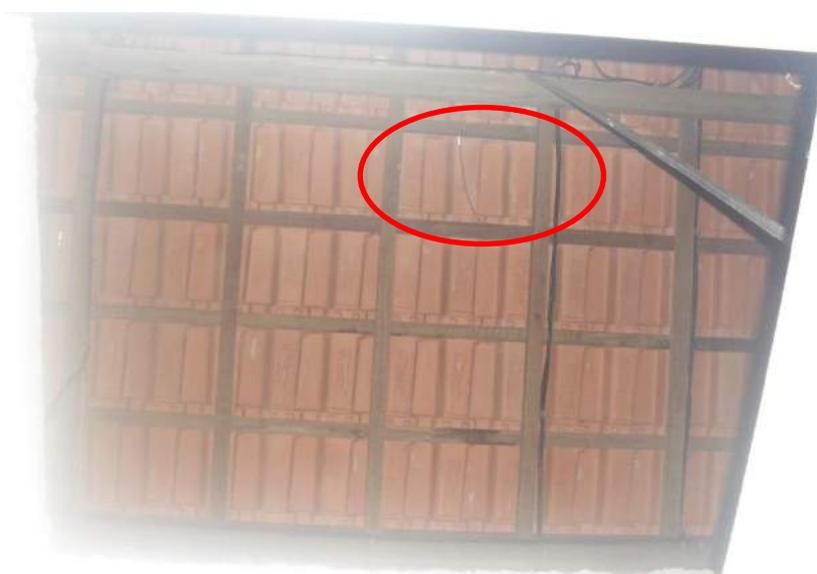
Foto 15 – Telha quebrada a ser substituída
