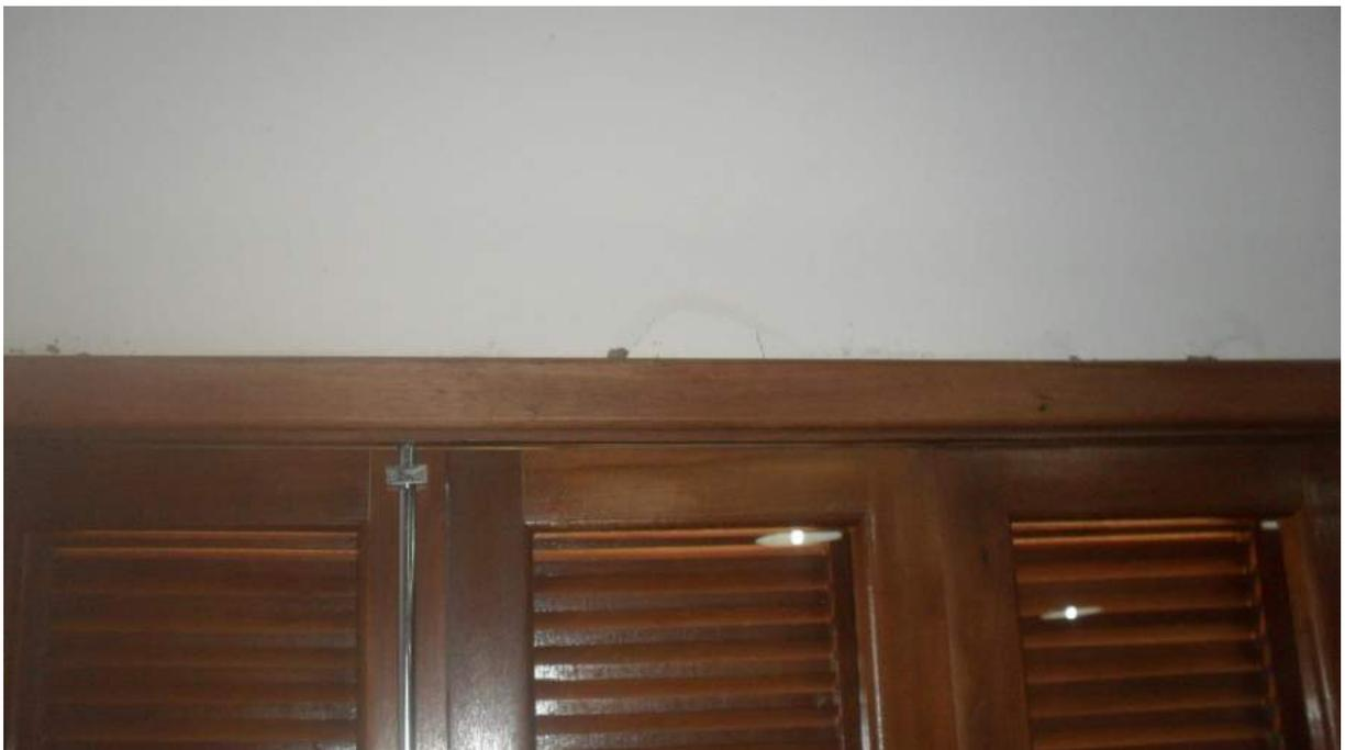
Foto 54 – Refazer o revestimento sobre o batente da janela
