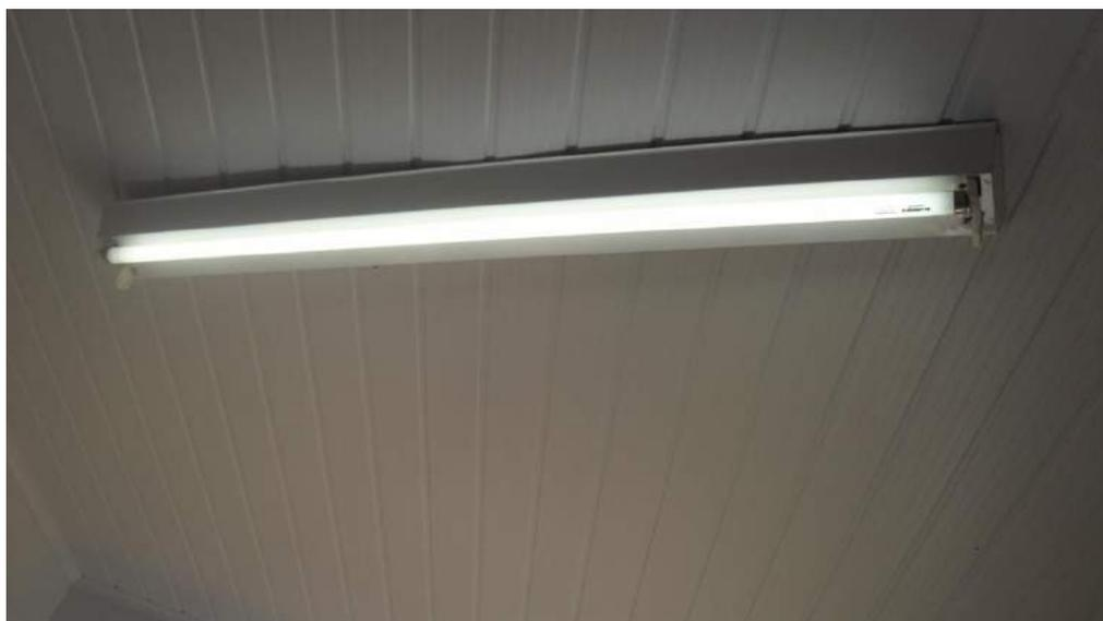
Foto 30 – Substituir por duas lâmpadas tubulares de led
