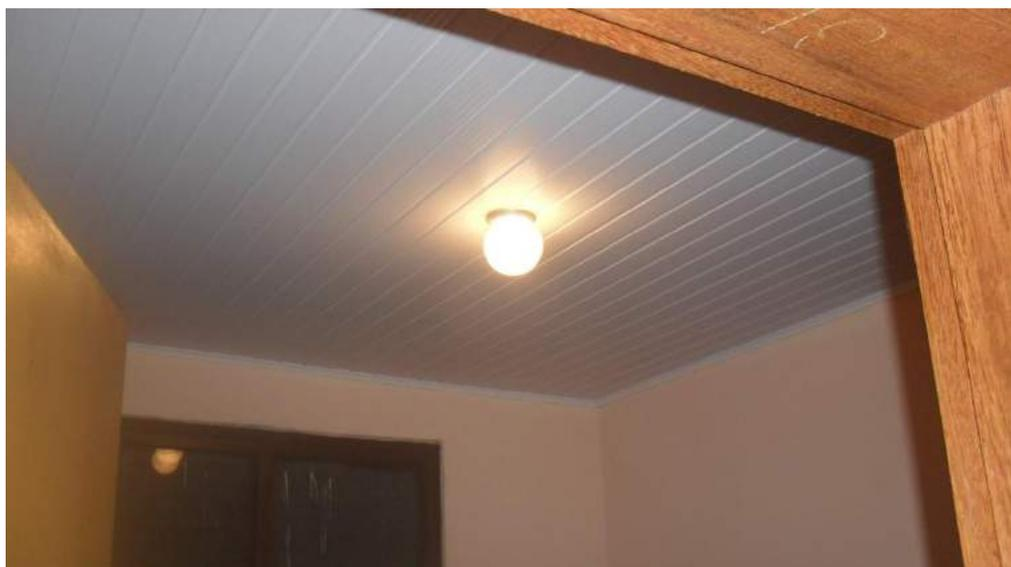
Foto 34 – Substituir por lâmpada de bulbo em led e colocar globo de vidro transparente
