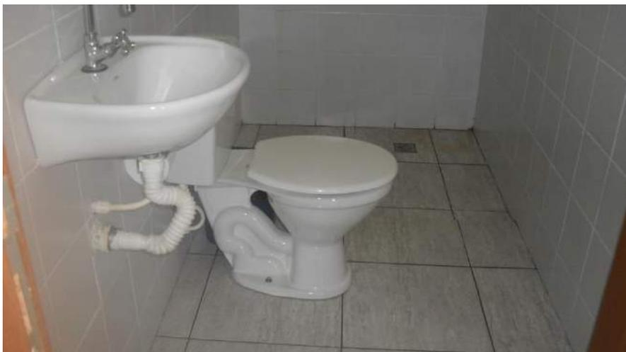
Foto 38 – Sifão retorcido, trincado e com vazamento
