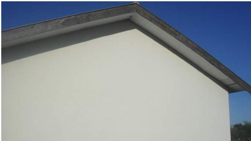
Foto 8 – Deterioração da pintura da madeira
