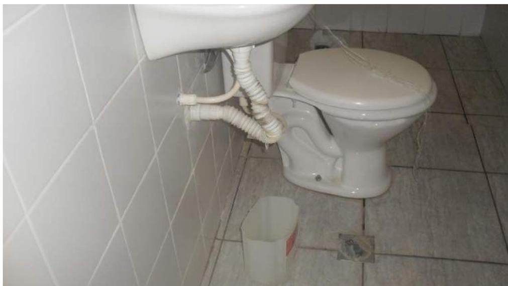
Foto 35 – Sifão retorcido, trincado e com vazamento.
