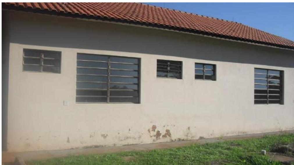
Foto 44 – A deterioração da pintura é mais acentuada no trecho próximo da calçada
