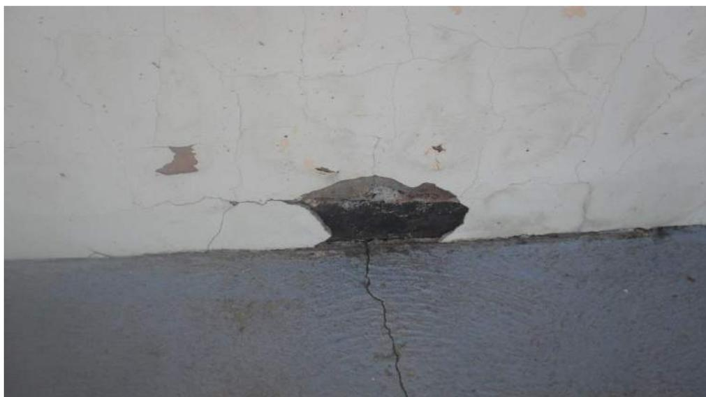
Foto 7 – Fissuras e desprendimento do emboço
