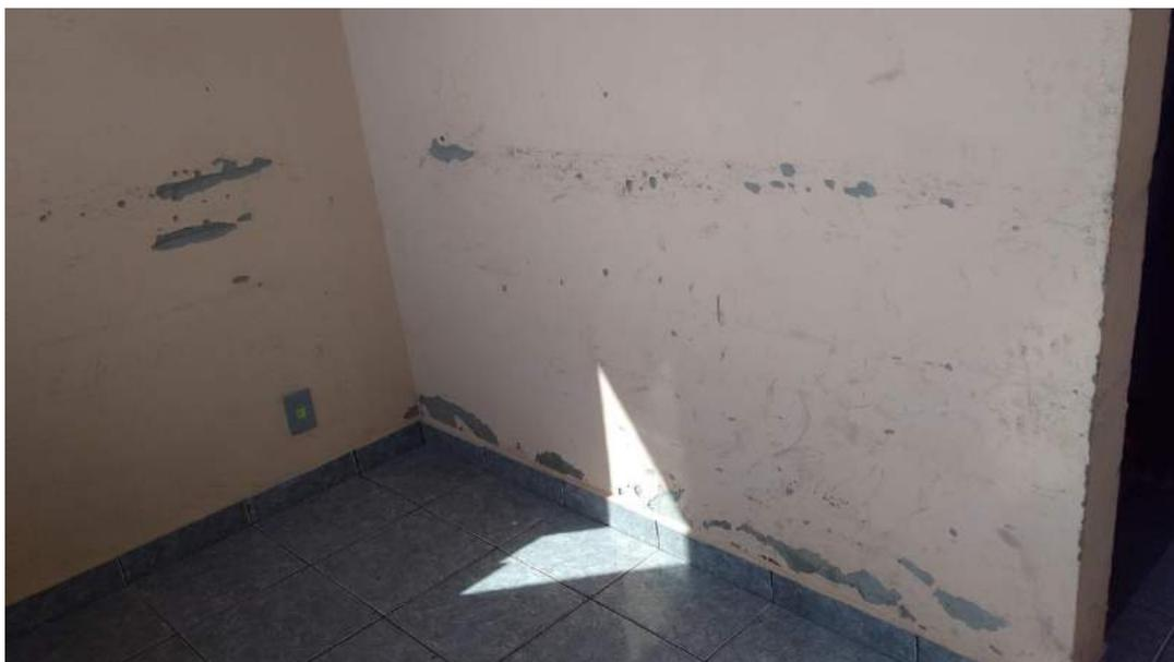
Foto 79 – Descascamento da pintura interna
