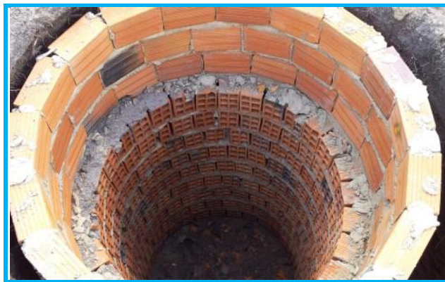
Figura 9 – Exemplo de sumidouro de pré-moldado e de alvenaria.
