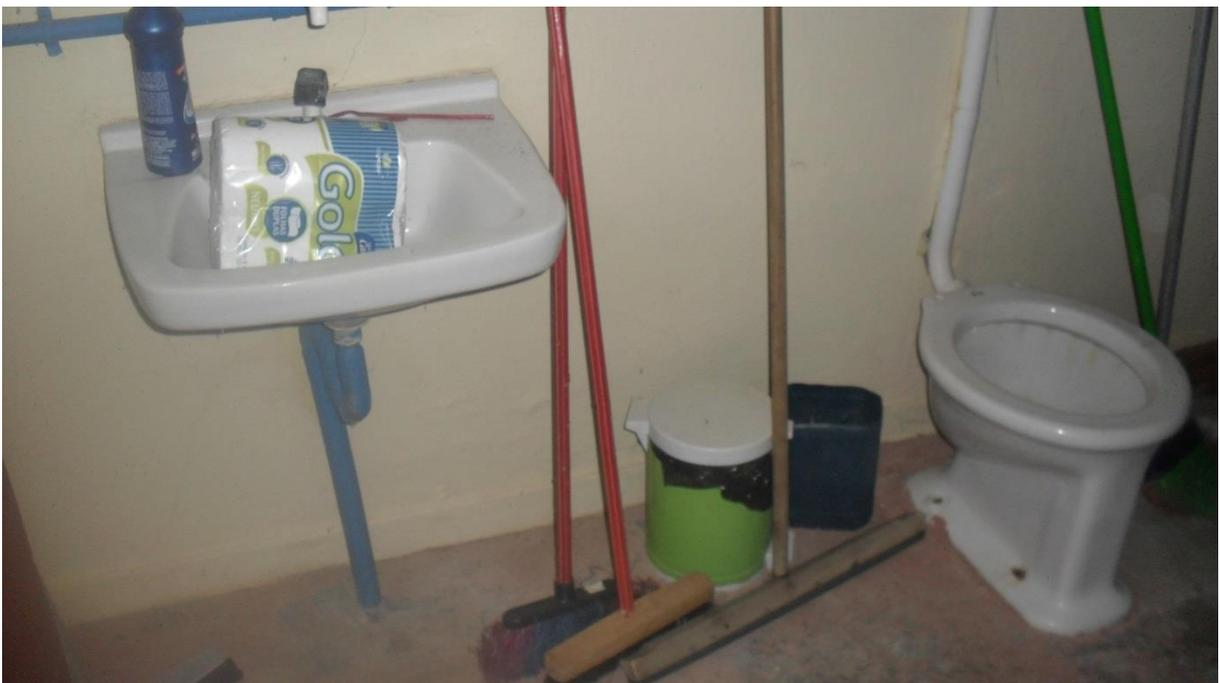
Foto 22 – Banheiro sem barra impermeável – bacia e lavatório
