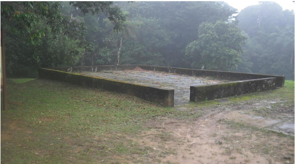
Foto 38 – Piso existente para implantação da estrutura em madeira para cobertura
