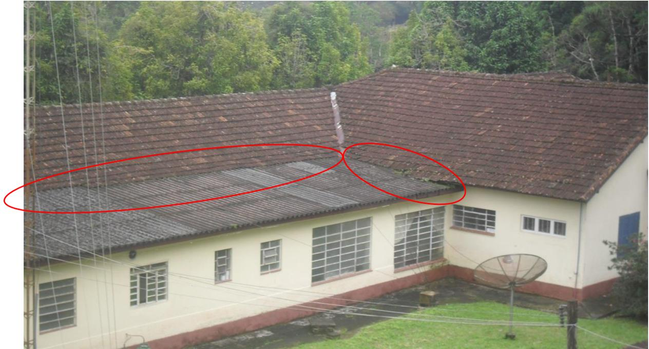
Foto 5 – Emenda de telhado sem dispositivos contra infiltração
