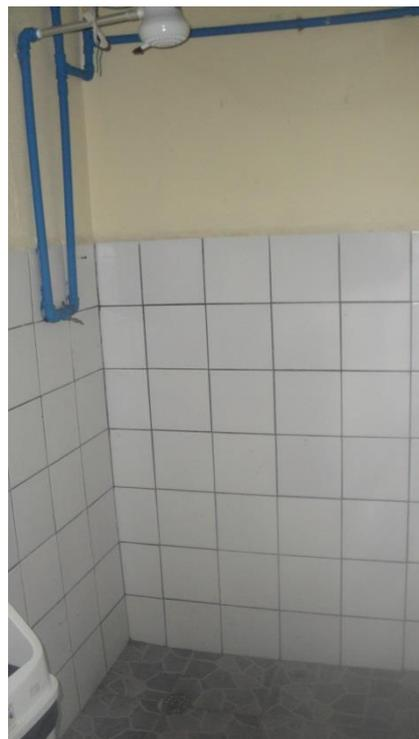
Foto 32 – Altura do chuveiro insuficiente
