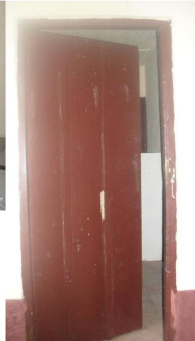
Foto 26 – Substituir batente e porta de entrada
