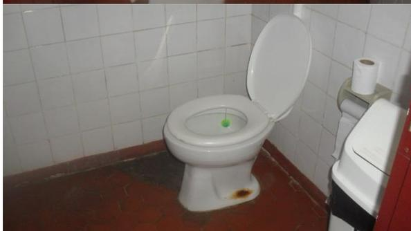
Fotos 13 e 14 – Bacias com desgaste devido à idade
