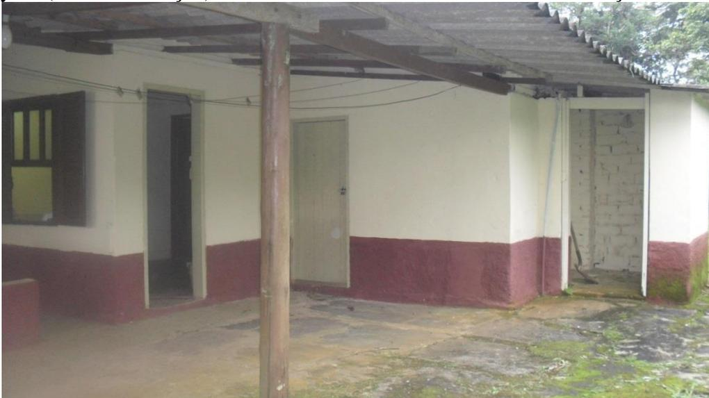
Foto 20 – Cobertura em telha de fibrocimento
