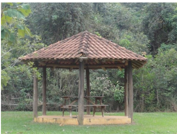
Reposição das telhas faltantes
