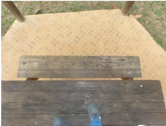
Manutenção dos bancos com mesa com verniz marítimo
