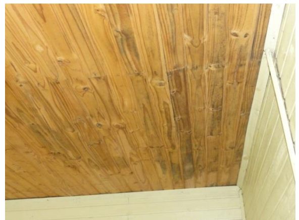
Troca do forro
