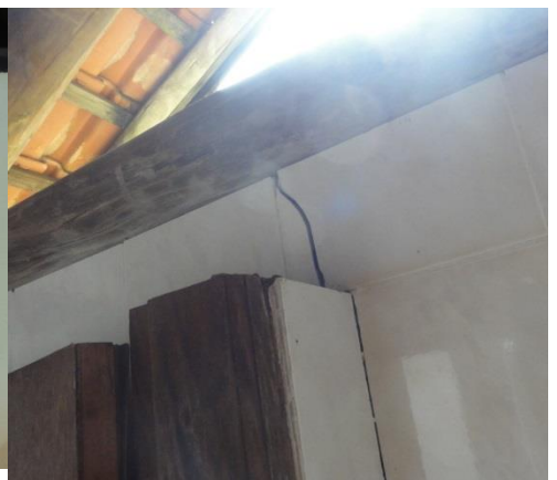
Travamento da parede com barra de ferro
