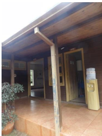
Troca do forro
