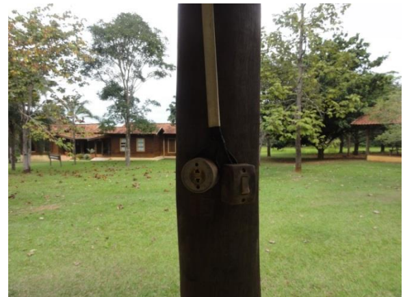
Verificação da parte elétrica
