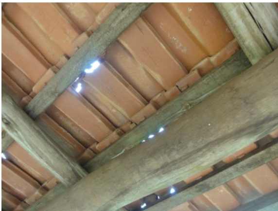
Substituição de telhas quebradas
