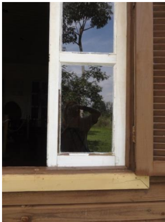
Manutenção das vidraças
