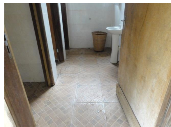
Hidrojateamento do piso
