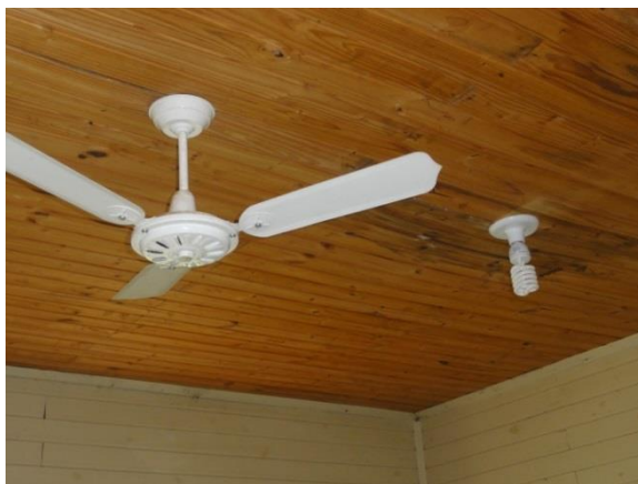
Troca do forro
