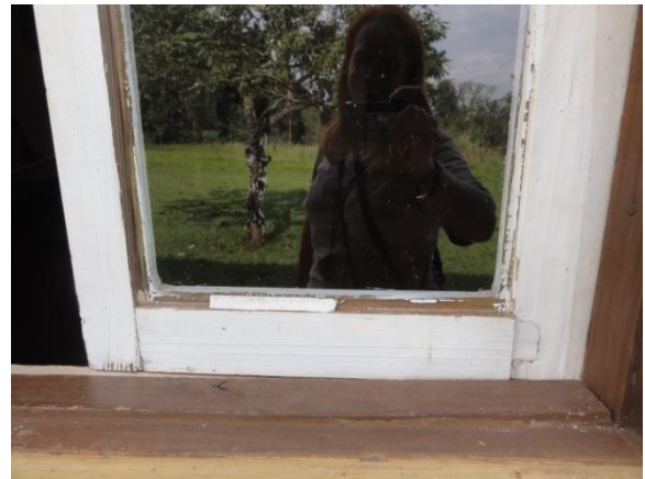
Detalhe da Manutenção das vidraças
