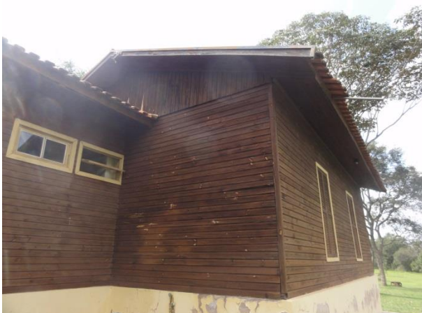
Parede com umidade, movimentação de telha
