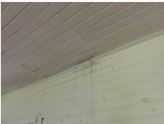
Verificação da cobertura
