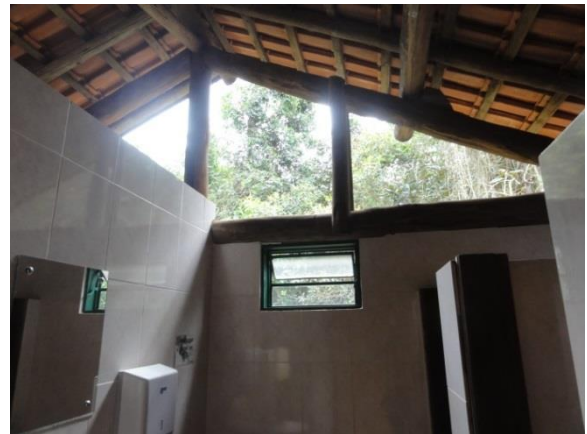
Sanitário Feminino (SF)
