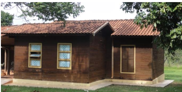
Troca das Calhas
