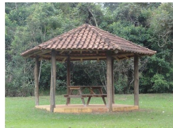
Manutenção da base do quiosque
