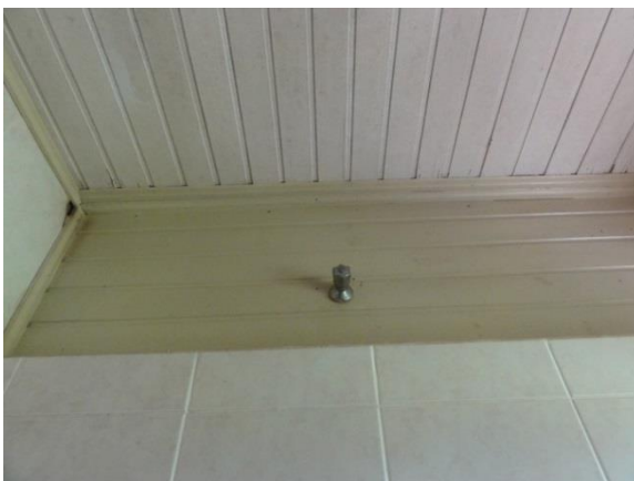
Troca do forro
