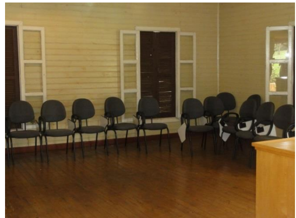
Troca da parede de madeira
