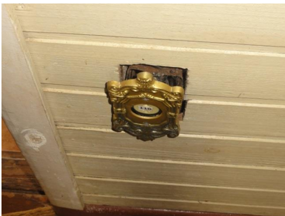
Troca da iluminação
