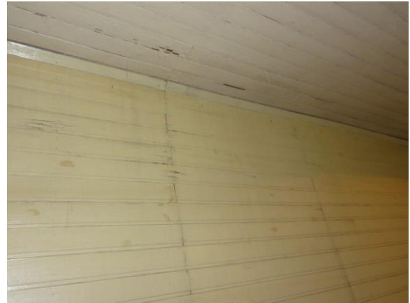
Troca do forro
