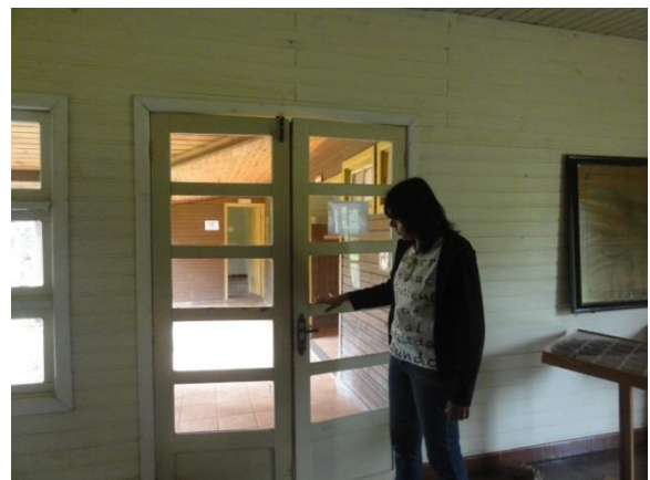
Verificação das esquadrias
