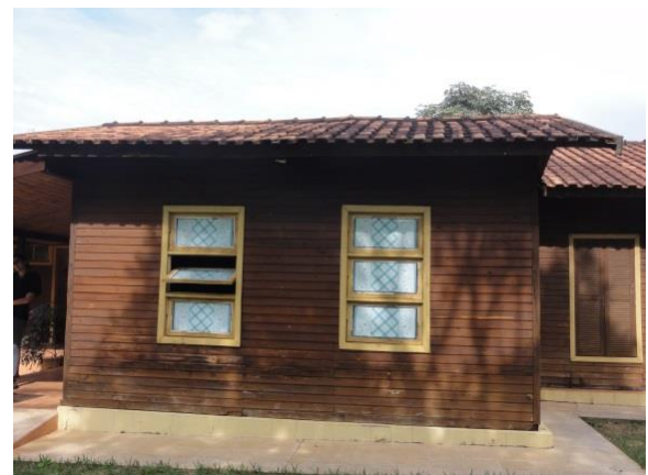
Verificação da Cobertura
