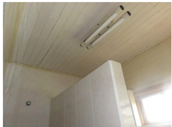
Troca do forro
