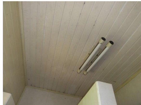
Troca do forro
