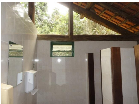
Sanitário Feminino (SF)
