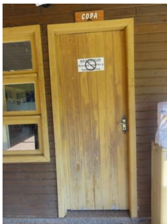
Manutenção da pintura
