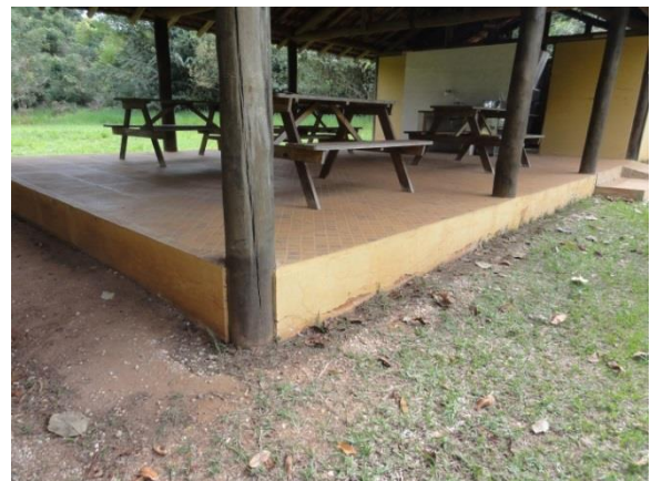
Manutenção do madeiramento
