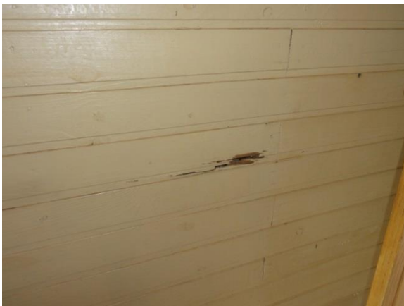
Troca do forro
