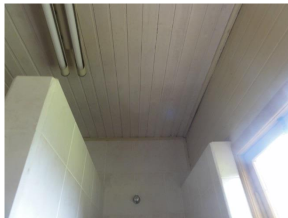
Troca da iluminação
