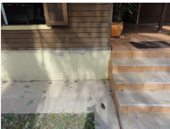
Hidro jateamento na calçada e escada
