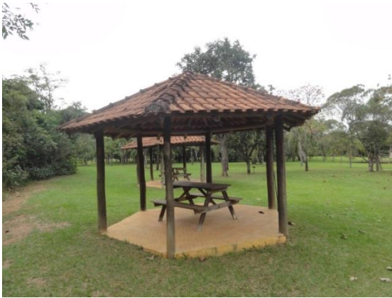
Pintura com verniz Marítimo
