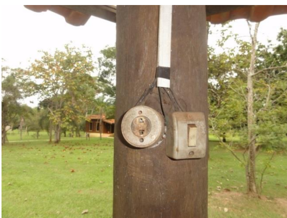
Verificação da parte elétrica
