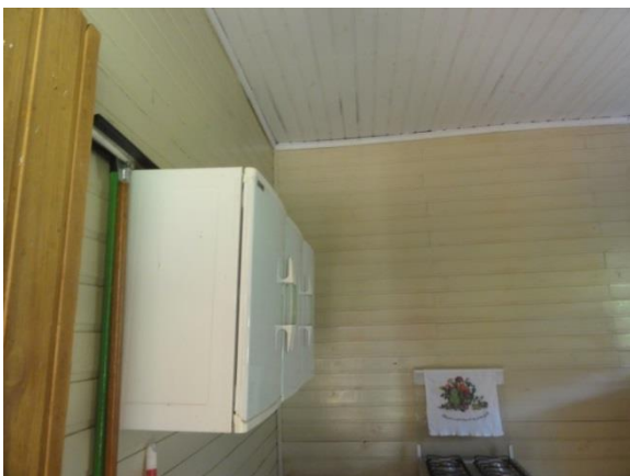
Troca do forro
