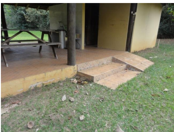
Pintura da base e parede
