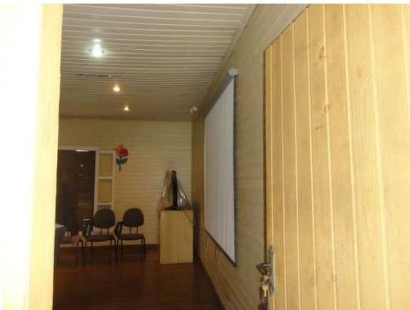
Troca do forro
