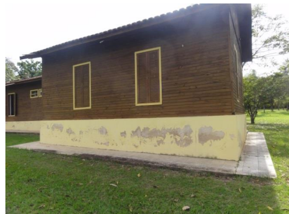
Lixamento e impermeabilização polimérica de toda a base do Centro de Visitantes
