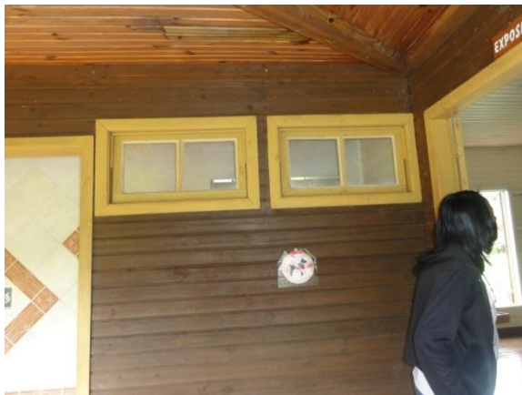
Troca do forro
