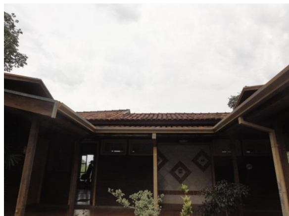
Verificação da cobertura
