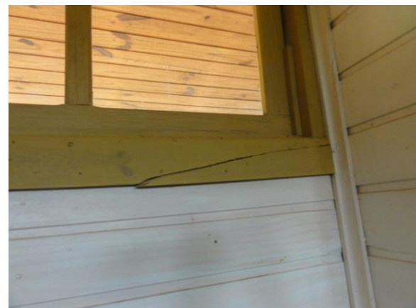
Manutenção do batente
