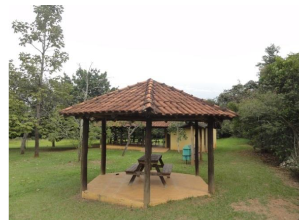
Limpeza do piso e cobertura
