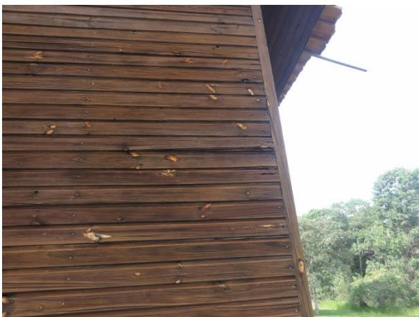
Parede com umidade, movimentação de telha
