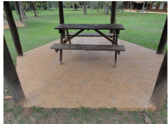
Hidrojetamento do piso e cobertura
