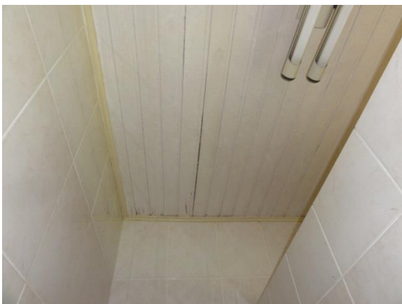
Troca do forro
