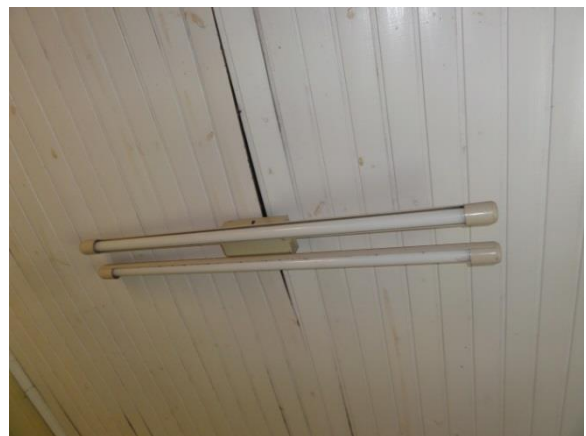
Verificação da cobertura
