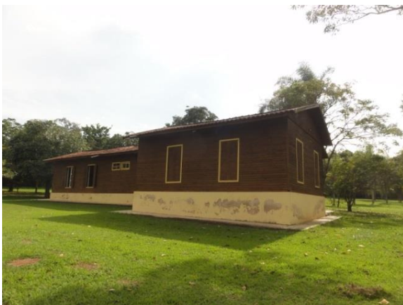
Lixamento e impermeabilização polimérica de toda a base do Centro de Visitantes
