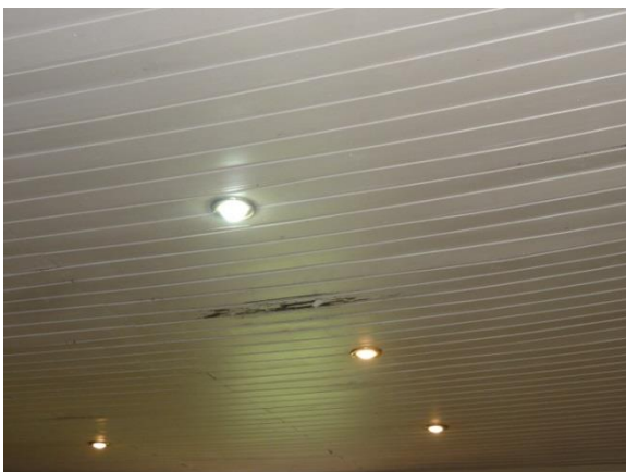
Troca do forro
