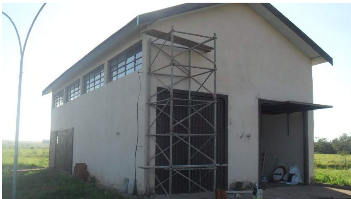
Foto 75 – Fachada Principal da Oficina
