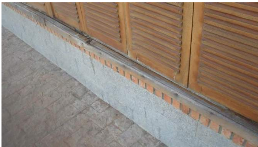
Foto 48 – Barrado executado no Centro de Visitantes
