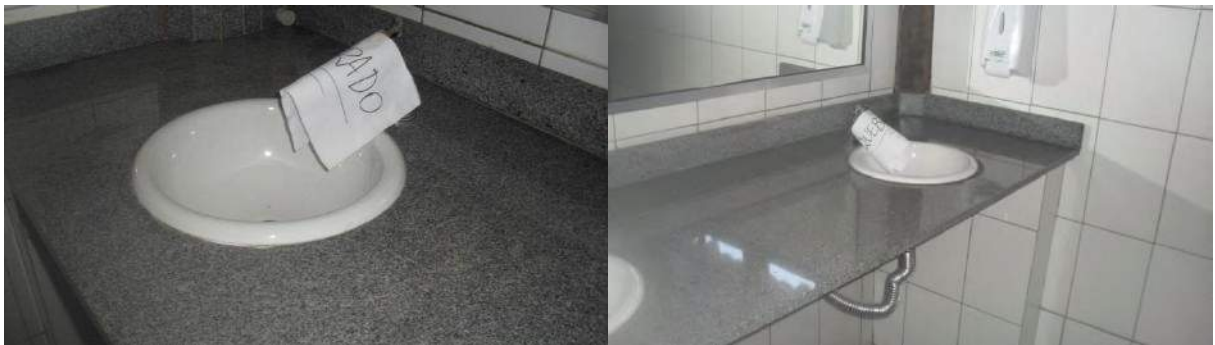
Fotos 63 e 64– Substituir as torneiras
