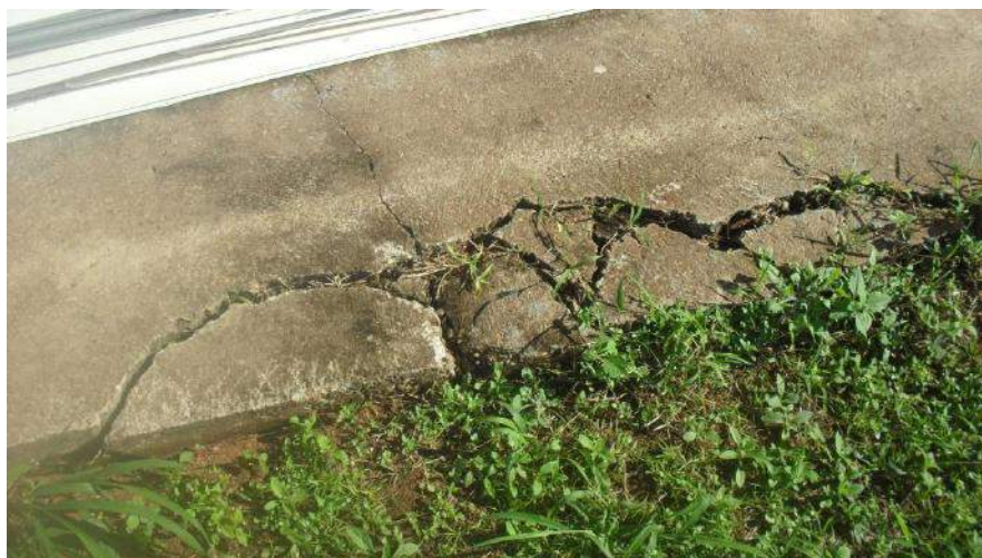
Foto 43 – Quebra causada pela roda de veículo
