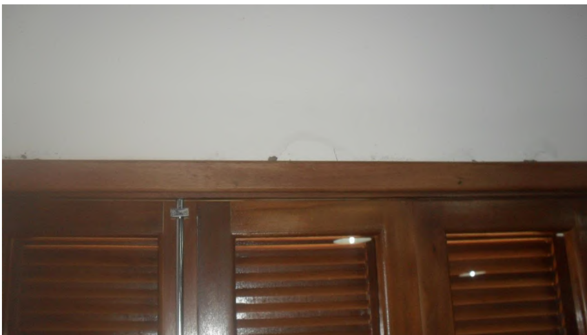
Foto 54 – Refazer o revestimento sobre o batente da janela
