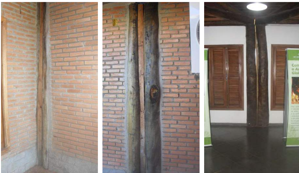
Fotos 58, 59 e 60 – Faltam linearidade nas peças de eucalipto
