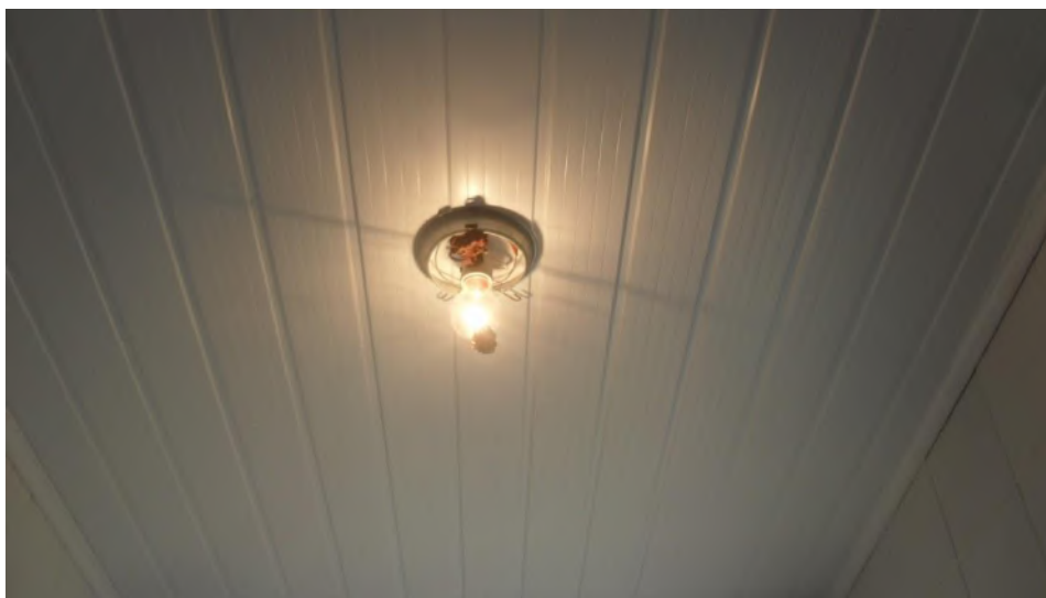
Foto 31 – Substituir por lâmpada de bulbo em led e colocar globo de vidro transparente
