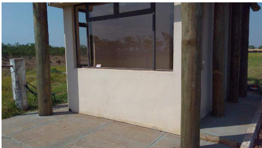
Foto 78 – Fachada da Guarita
