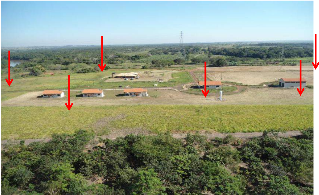
Fotos 74 – Vista aérea – locais para instalação
