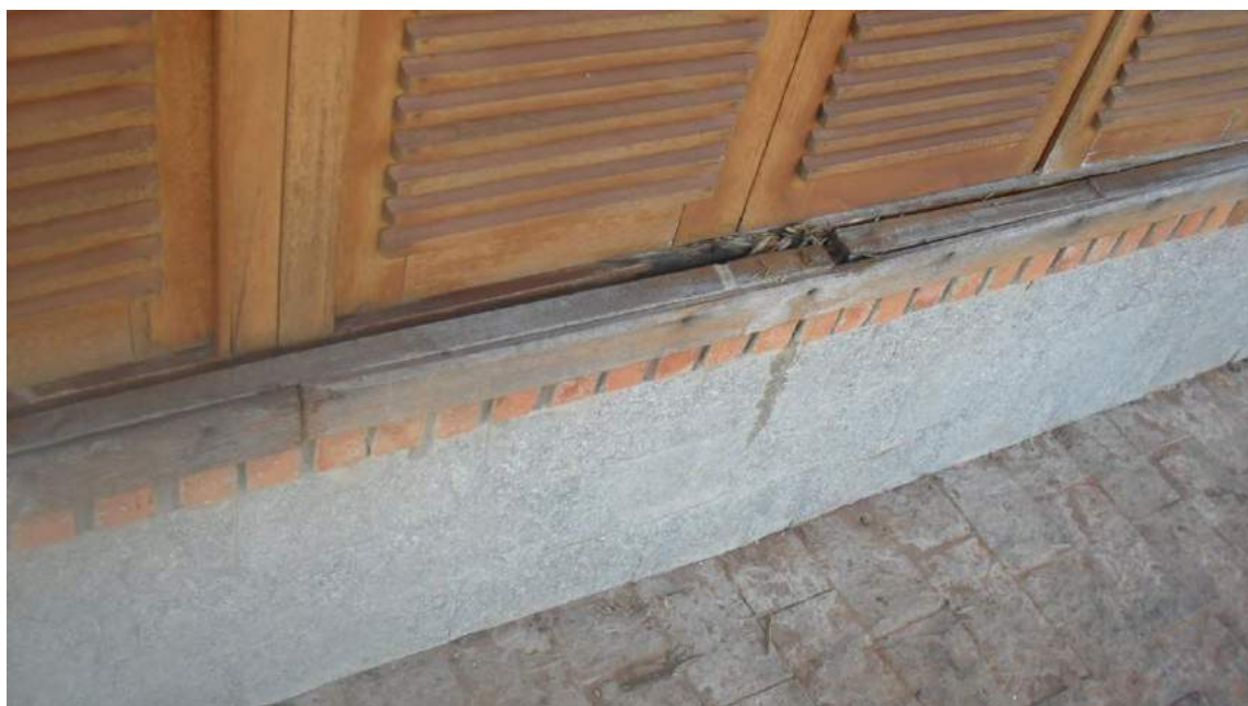
Foto 52 – A água retida nos trilhos apodreceram a base do batente
