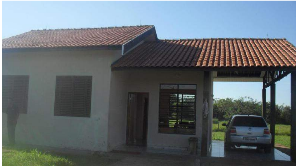
Foto 3 – Fachada Principal da Zeladoria
