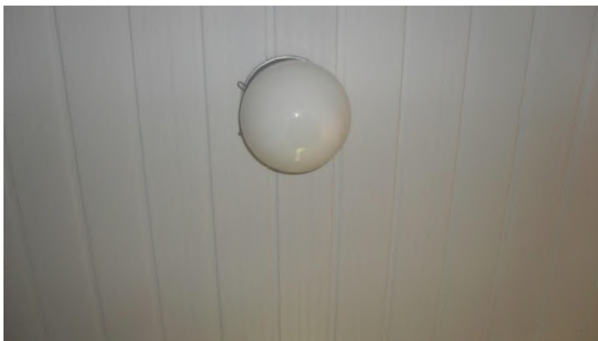
Foto 32 – Substituir por lâmpada de bulbo em led e colocar globo de vidro transparente
