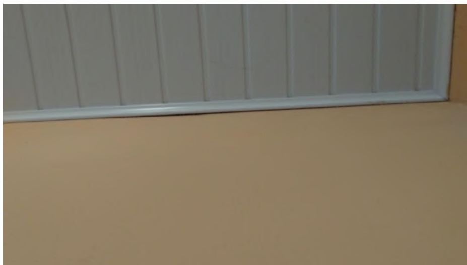
Foto 33 – Colocação de Silicone para vedação dos forros de PVC
