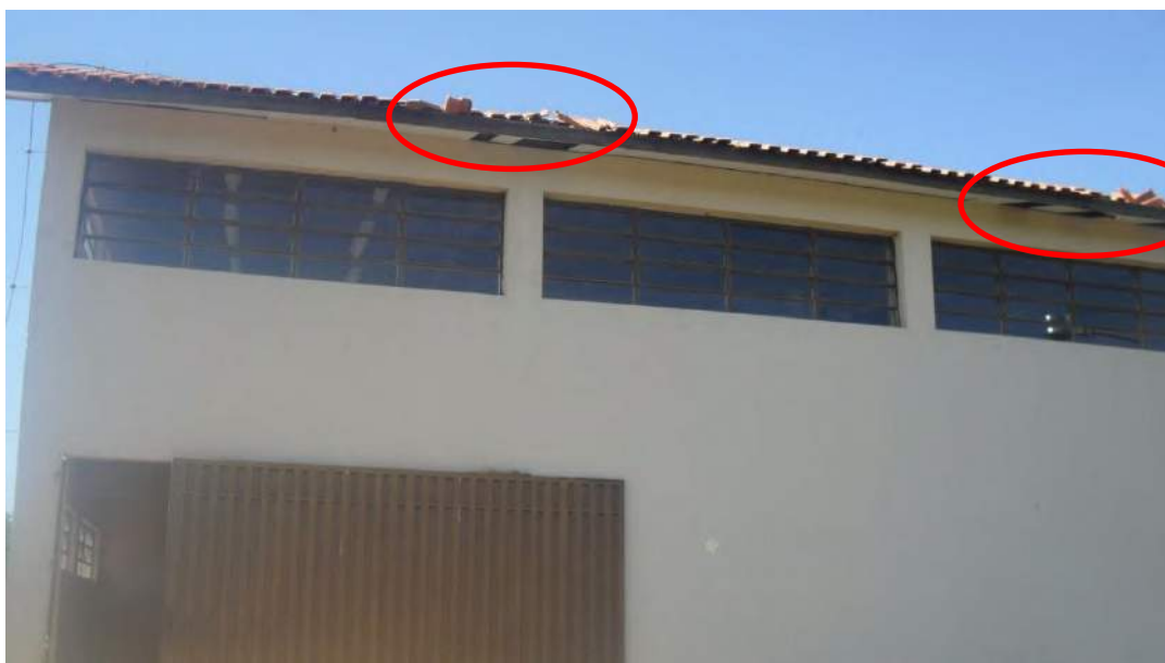
Foto 77 – Refazer forro, ajustar ou substituir telhas
