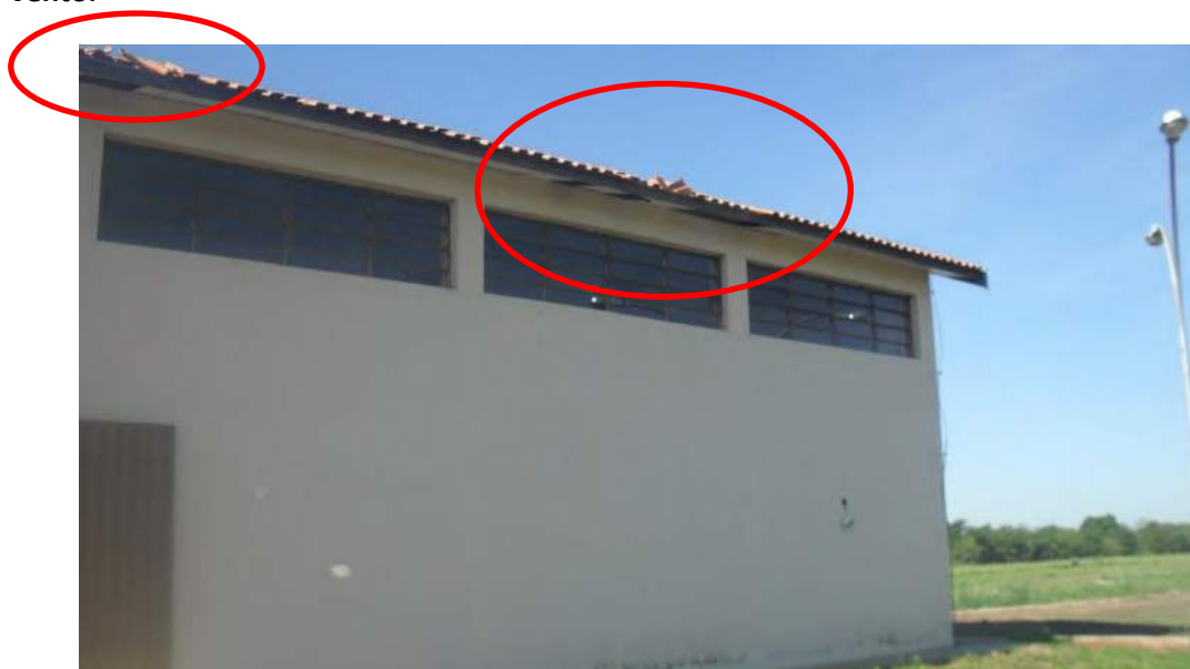
Foto 76 – Refazer forro e telhamento
