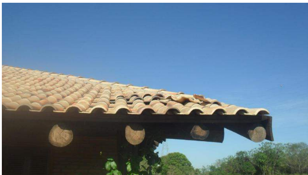
Foto 61 – Realinhamento / Substituição de telhas e cumeeiras
