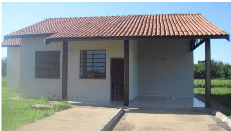
Foto 4 – Fachada Principal do Alojamento
