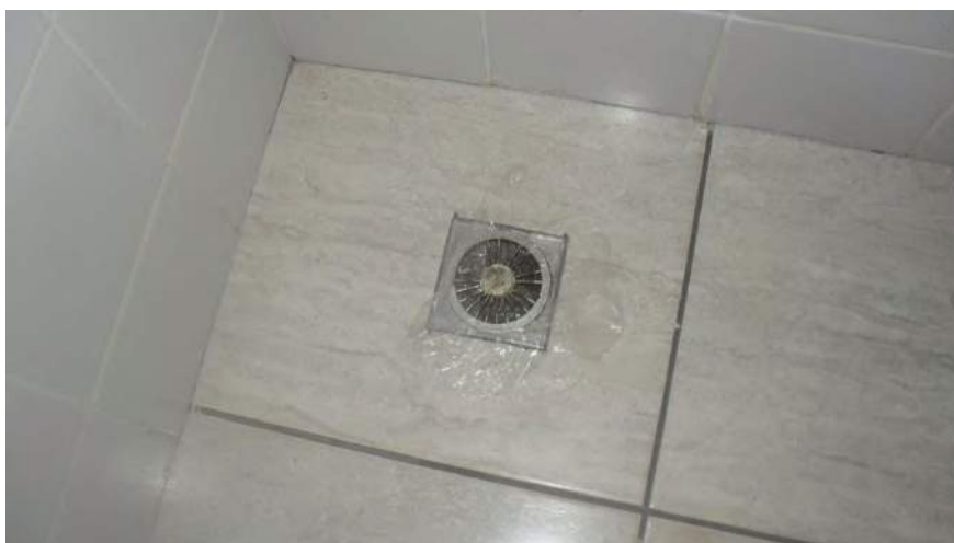
Foto 40 – Paliativo para impedir desprendimento de gases no banheiro
