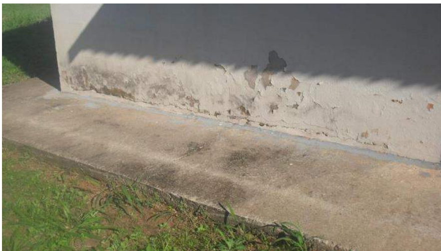
Foto 47 – A possibilidade de a umidade afetar o ambiente interno é significativa
