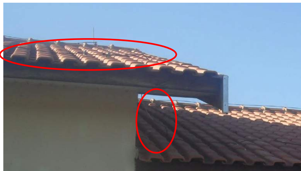
Foto 21 – Malha sobre o telhado – Não localizada a descida
