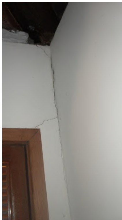
Fotos 56 e 57 – Fazer amarração da alvenaria com o pilar de eucalipto
