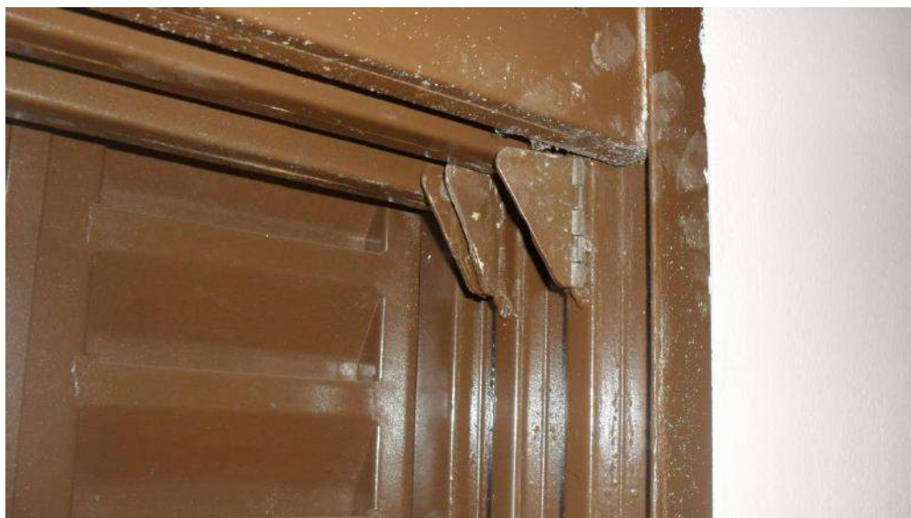
Foto 26 – Borboleta precisando de ajuste ou substituição
