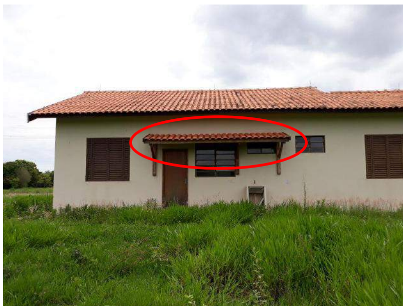
Foto 49 – Ampliação da Varanda da Cozinha (Zeladoria e Alojamento 1 e 2)
