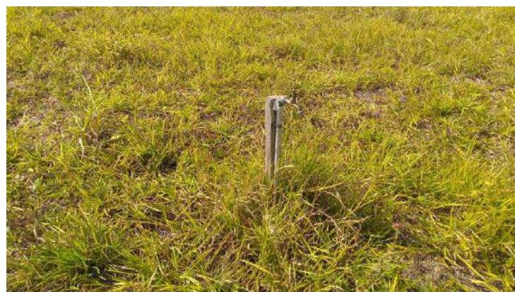
Foto 68 – Torneiras sem reforço
