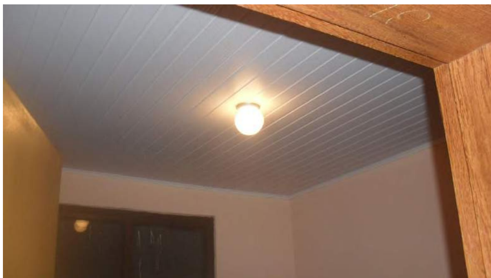
Foto 34 – Substituir por lâmpada de bulbo em led e colocar globo de vidro transparente
