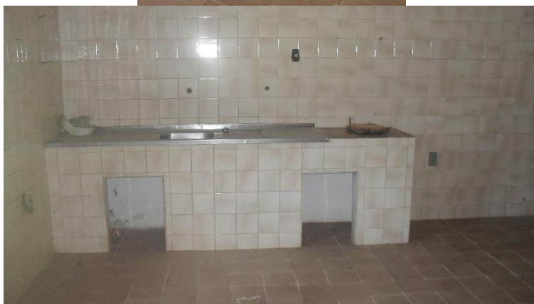
Fotos 6 e 7 – Substituir azulejos Banheiros /Cozinha e Área de Serviço
