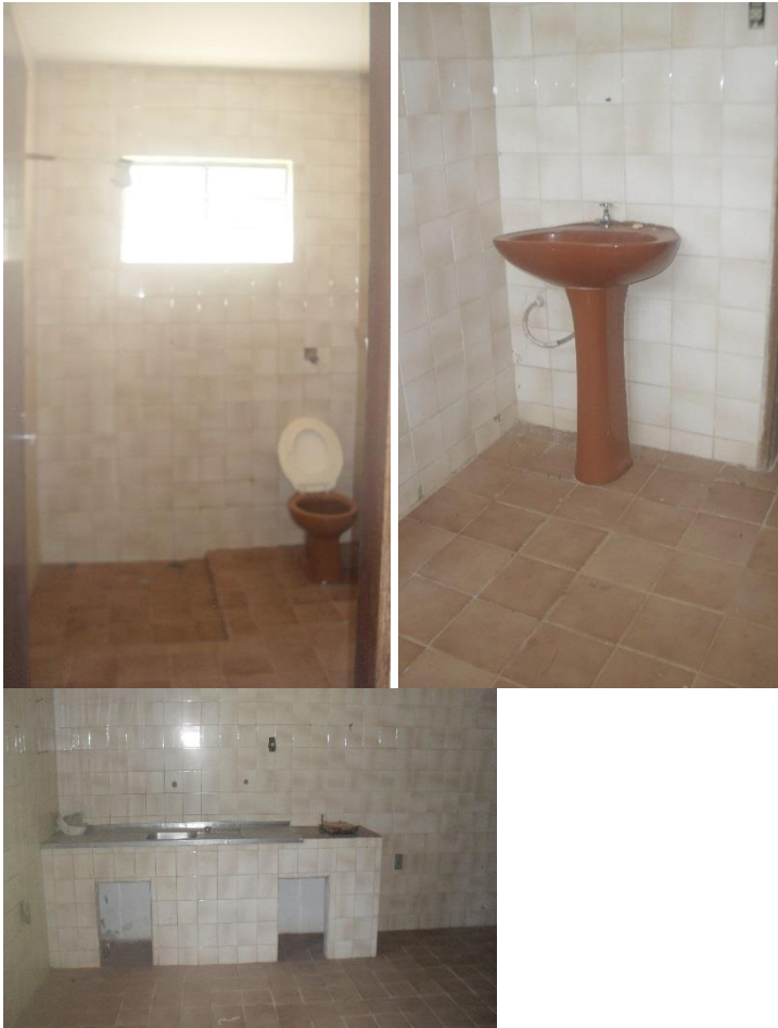
Fotos 12, 13 e 14 – Instalar novos acessórios hidráulicos
