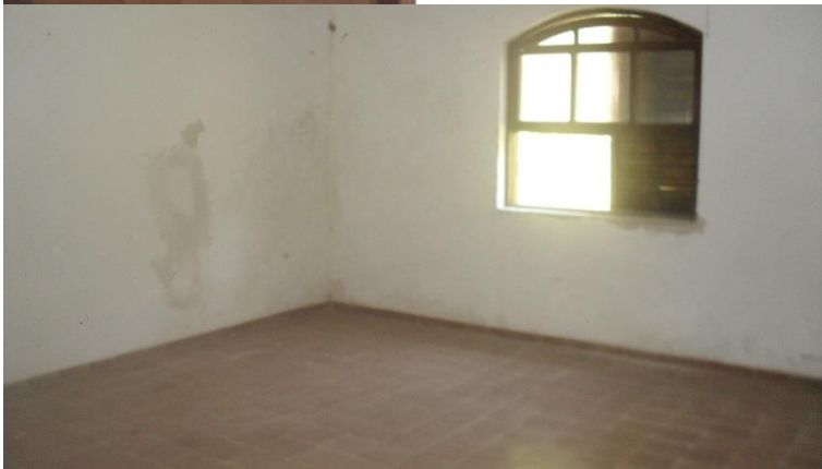
Fotos 10 e 11 – Substituir pisos cerâmicos
