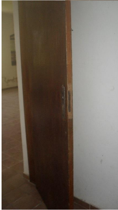
Fotos 15, 16 e 17 – Instalar novas esquadrias
