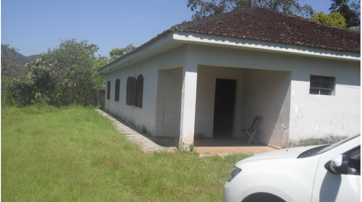
Foto 1 – Fachada Principal da Base Fiscalização do Núcleo Capinzal
