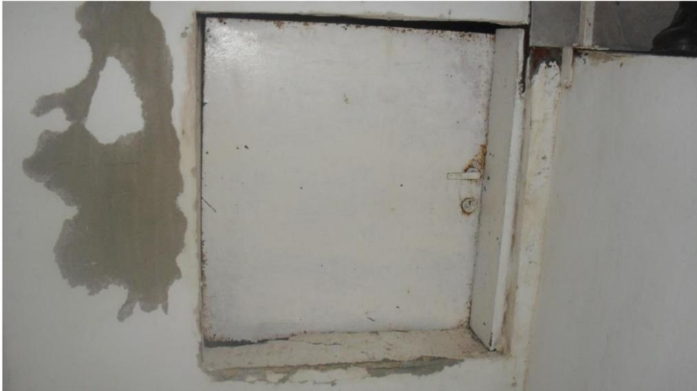
*Imagens 28 – Porta de ferro e parede deteriorada por conta da umidade*
