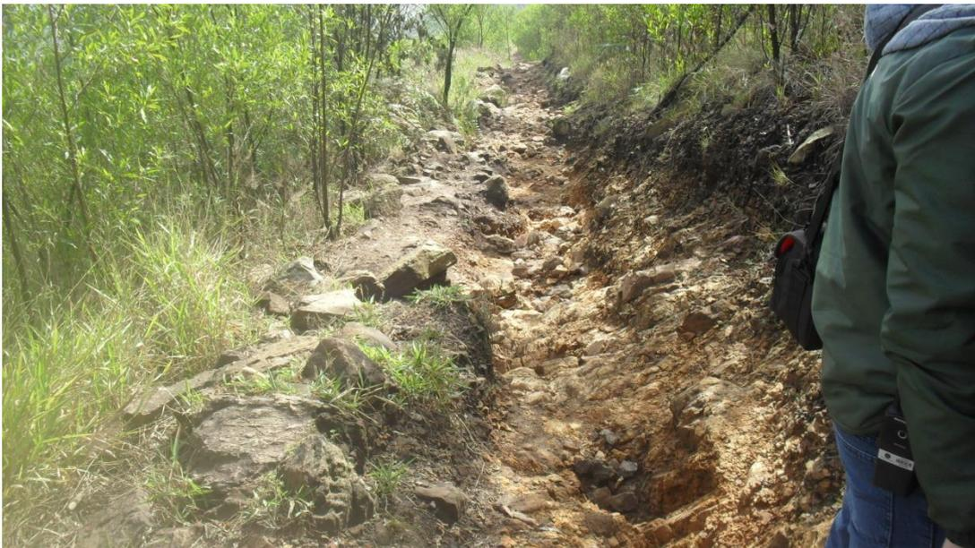
*Imagem 37 – Exemplo de pontos a serem regularizados através de movimentação de terra*
